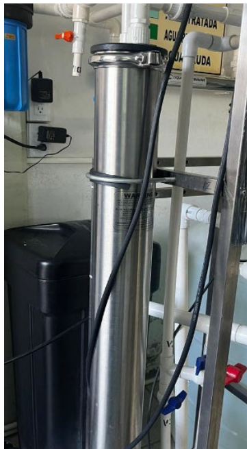
Figura 2.8. Filtro de ósmosis inversa.
