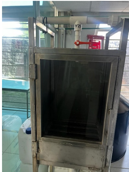
Figura 2.16. V21 o llave despachadora de agua purificada.
