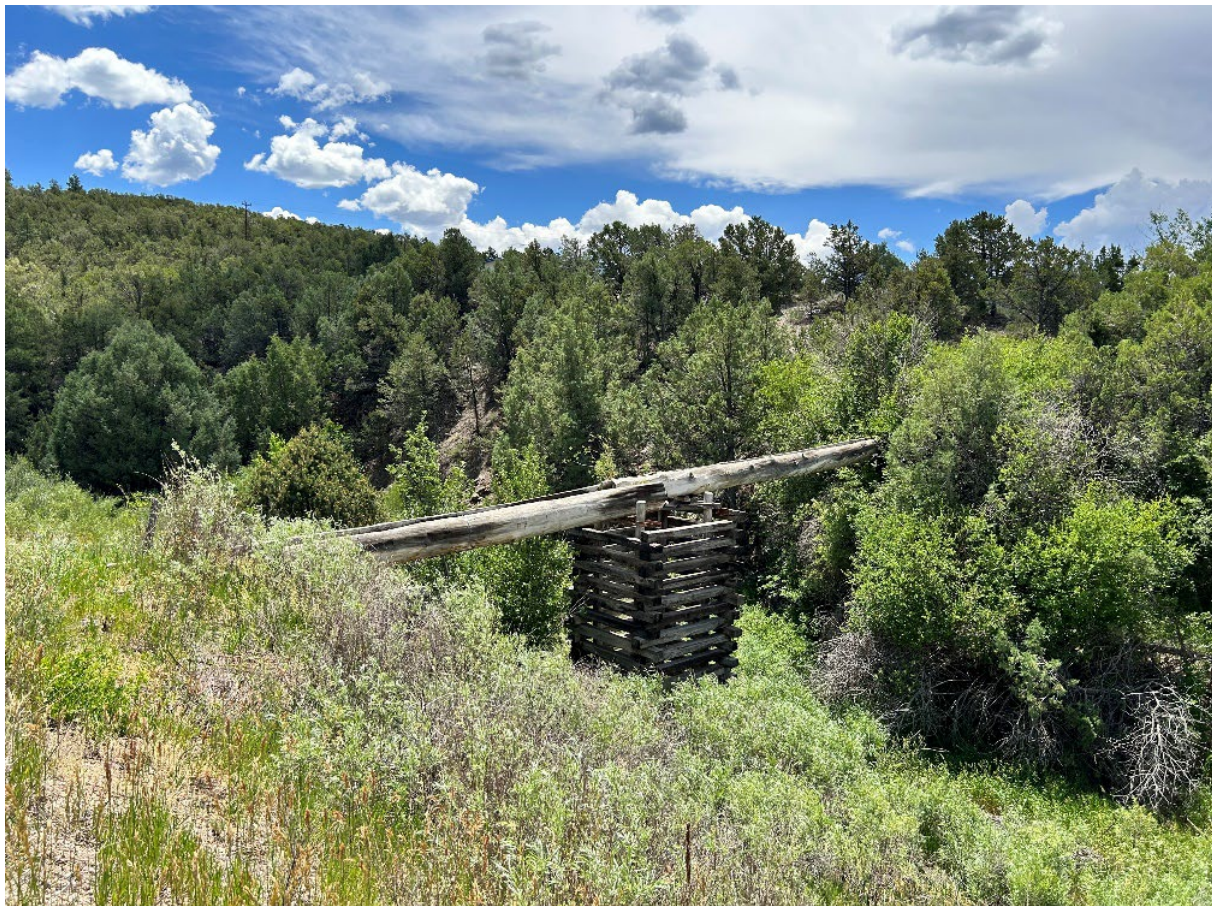
Imagen 13. Tochimilco, no es el único territorio que fue transformado a partir de infraestructuras. Por ejemplo, cerca de la población la Española en Nuevo México se observa una canoa todavía en funcionamiento; se trata de un puente construido con troncos ahuecados que sirve para salvar barrancas y hacer que el agua siga su curso a lo largo de la acequia. Fotografía propia,
