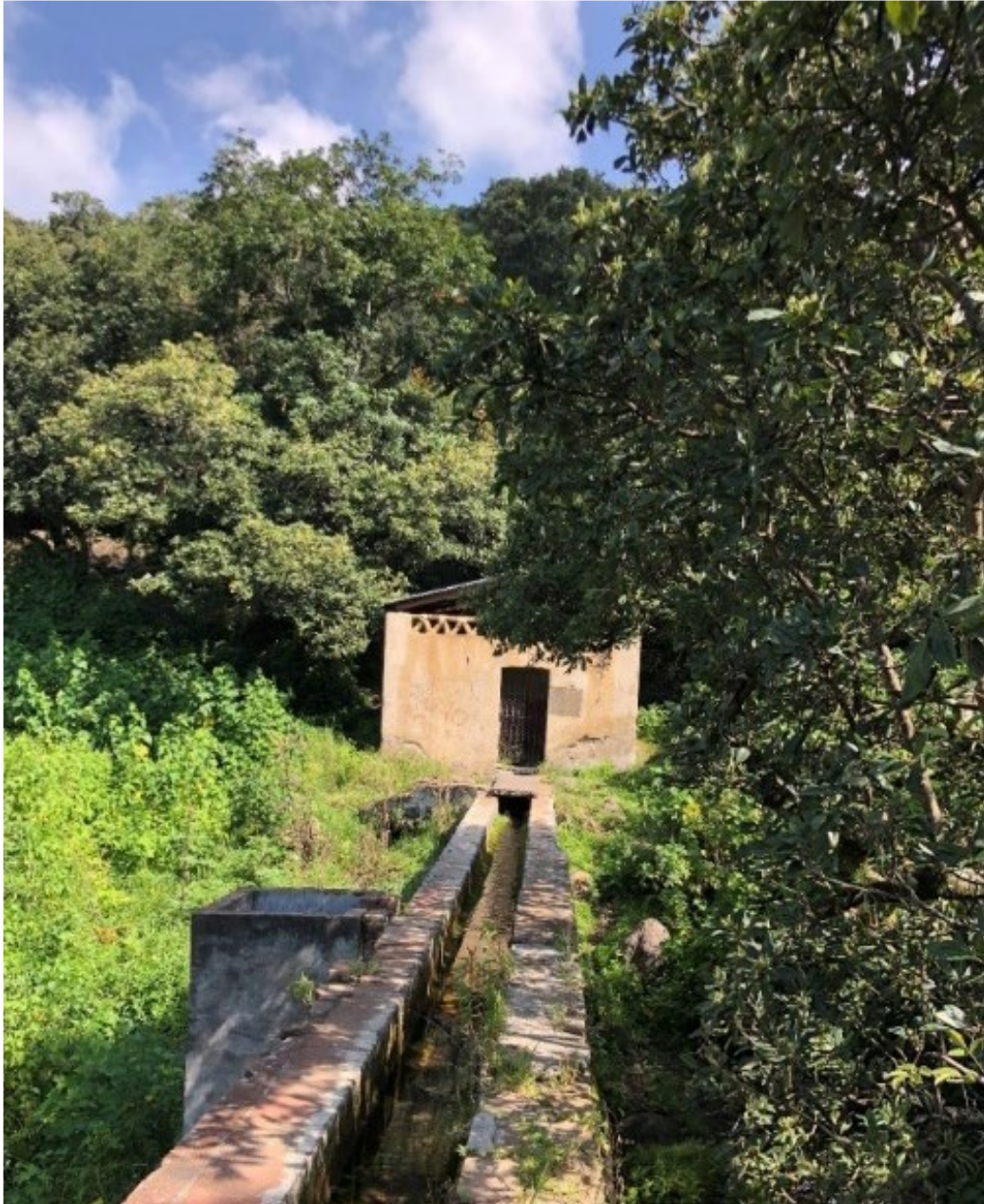
Imagen 15. Caja almacenadora. Capta y distribuye el agua que nace del manantial del Arco. Las soluciones técnicoconstructivas, así como los instrumentos administrativos buscaban el mejor aprovechamiento de agua además del reparto equitativo. Fotografía propia, 2019
