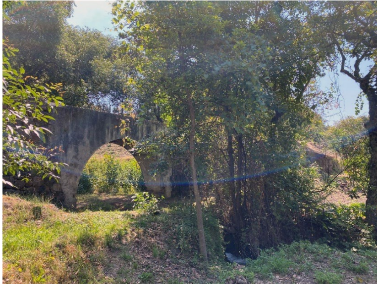
Imagen 16. Puente. Une la caja almacenadora en un lado, con la acequia elevada en el otro. Fotografía propia, 2022
