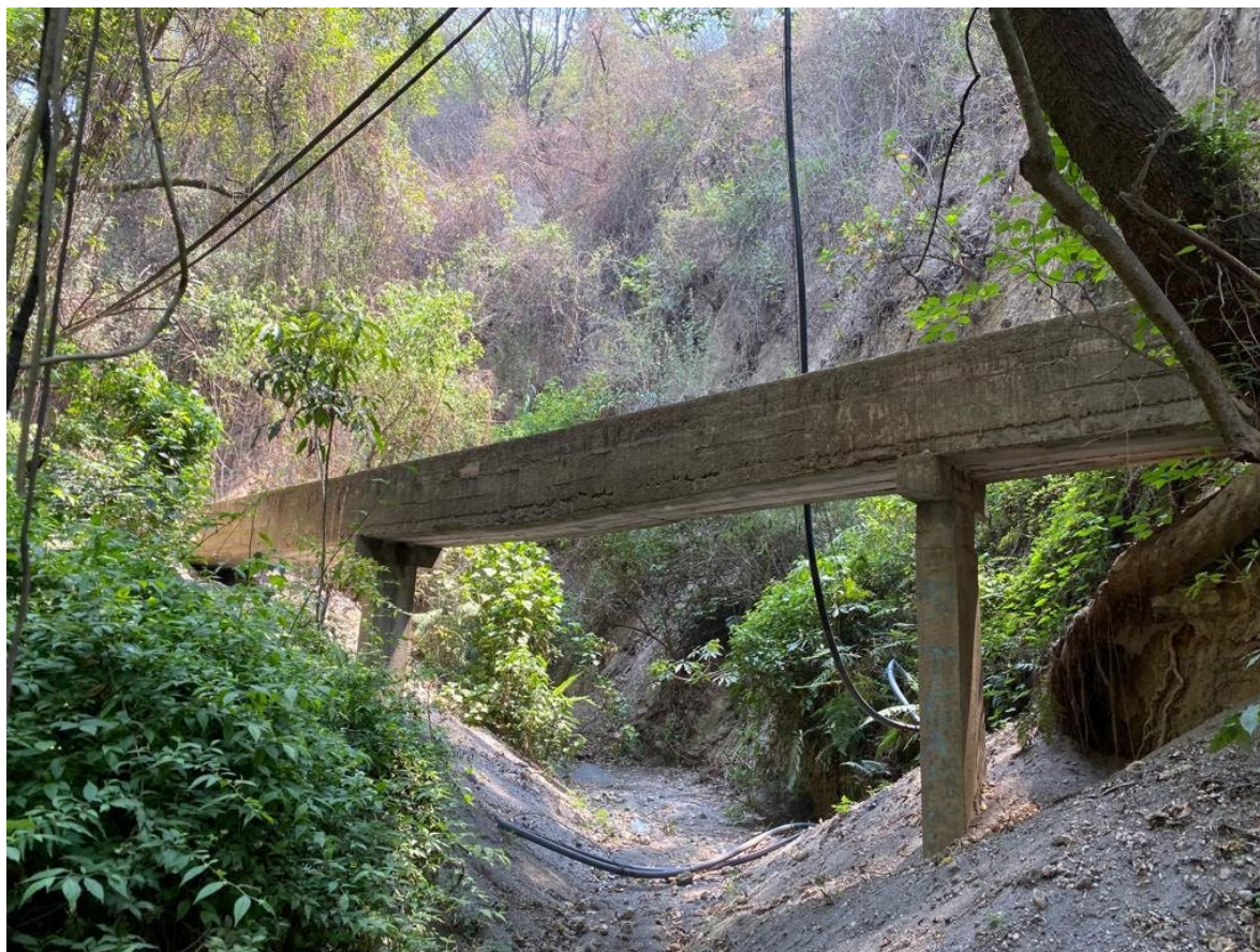
Imagen 29. Acequia elevada. Conduce el agua desviándola en la presa, en dirección del barrio de Xaxalpa. Fotografía propia, 2022
