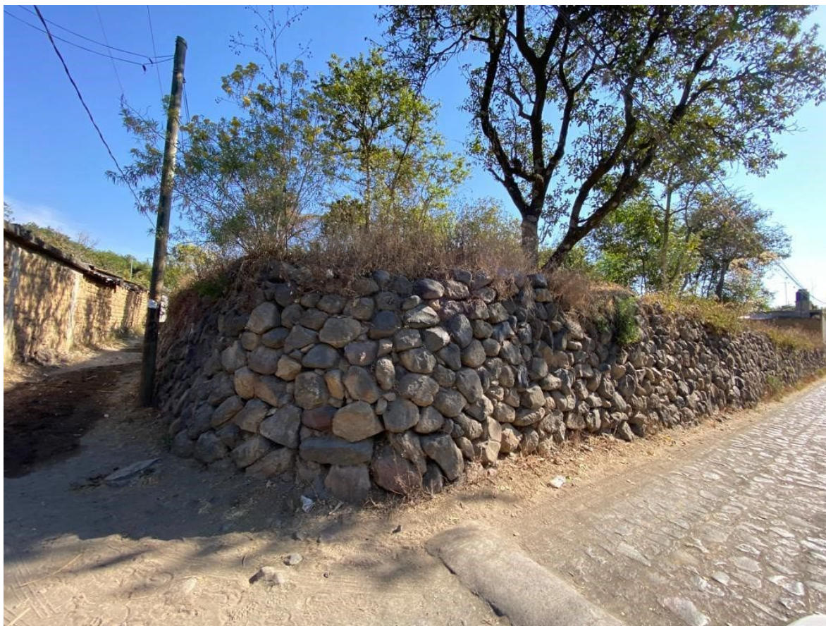
Imagen 12. Tecorral. Debido a los accidentes del terreno, se hizo necesario intervenir su topografía natural, son operaciones que incluyen canales, terraplenes, terrazas, cortes, rellenos, además de muros de contención, conocidos como tecorrales . Las terrazas y las diferentes obras hidráulicas, nos hablan del deseo de obtener más de una cosecha al año, aprovechando estas infraestructuras desarrolladas a lo largo de su dominio. Fotografía propia, 2023
