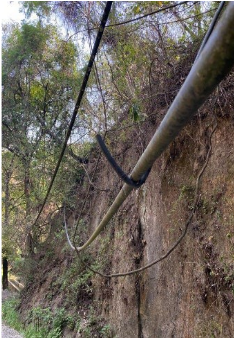
Imagen 19. Poliducto negro tipo manguera. La respuesta moderna, una red de mangueras que tienen un cometido meramente funcional, por lo que no aportan necesariamente a la construcción del paisaje, pero sí facilitan la gestión del sistema al ser un material que permite que el sistema crezca orgánicamente. Fotografía propia, 2022
