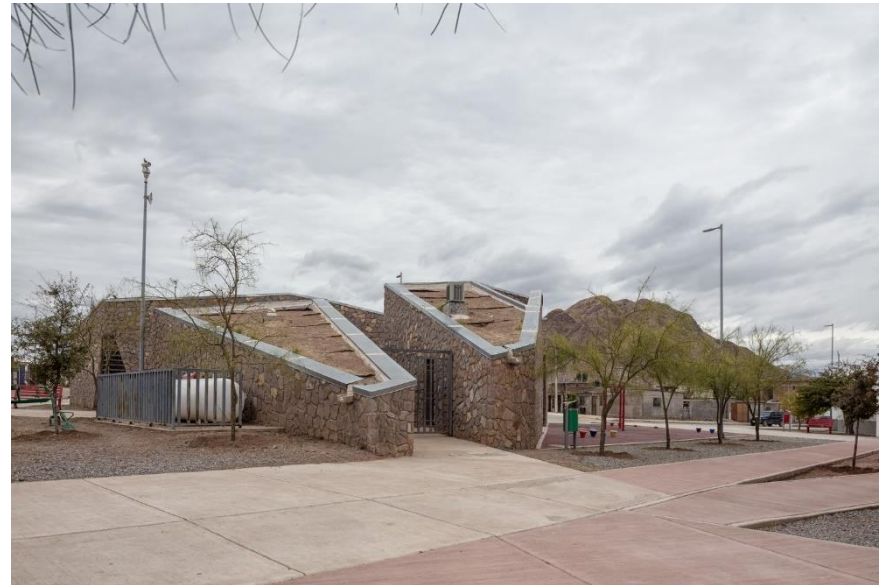
4.1.26 Imagen de la vista de cubiertas de conjunto del Centro comunitario Vistas de Cerro Grande, recuperado de: https://images.adsttc.com , agosto de 2018.
