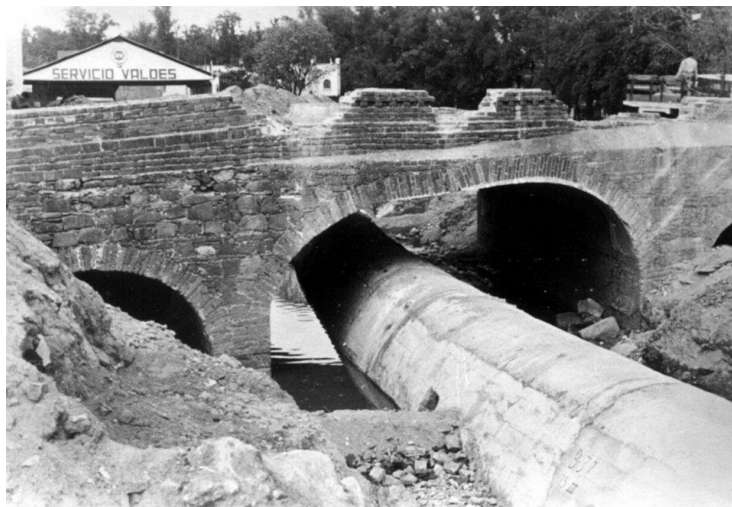
Figura 8: Entubamiento del río San Francisco. Construcción del bulevar Héroes del 5 de Mayo, a la altura de la iglesia de San Francisco. Fuente: Puebla Antigua.
