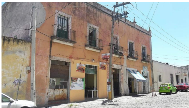
Figura 21: Inmueble en 5 oriente 1206, entre 12 y 14 sur. La fachada presenta una saturación de vanos (portales y acceso), pero por otra parte cuenta con más detalles de ornato como la cornisa y pináculos. Fotografía del autor (2017).
