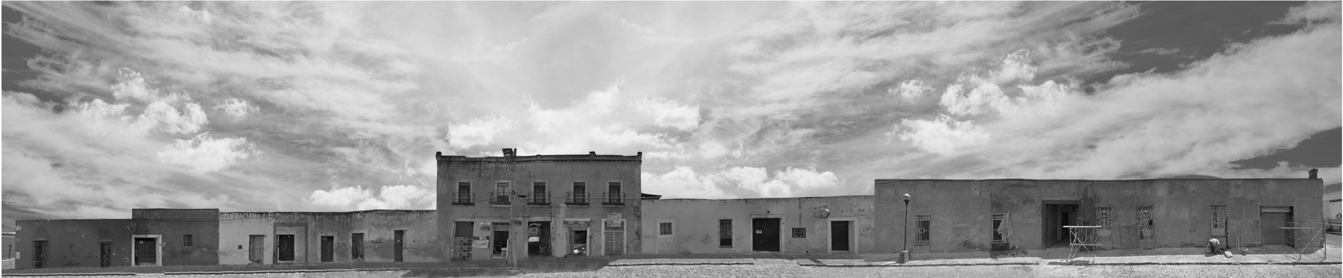
Perfil norte de Av. 5 oriente, entre 12 sur y 14 sur. Estado actual.
