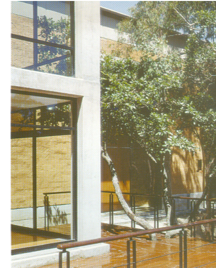
Fig.D Casa A+A. Estudio Arquitectura Arq. Federico Bautista Arq. Armando Mauleón 1996-1997 Fotografía: Luis Gordo
