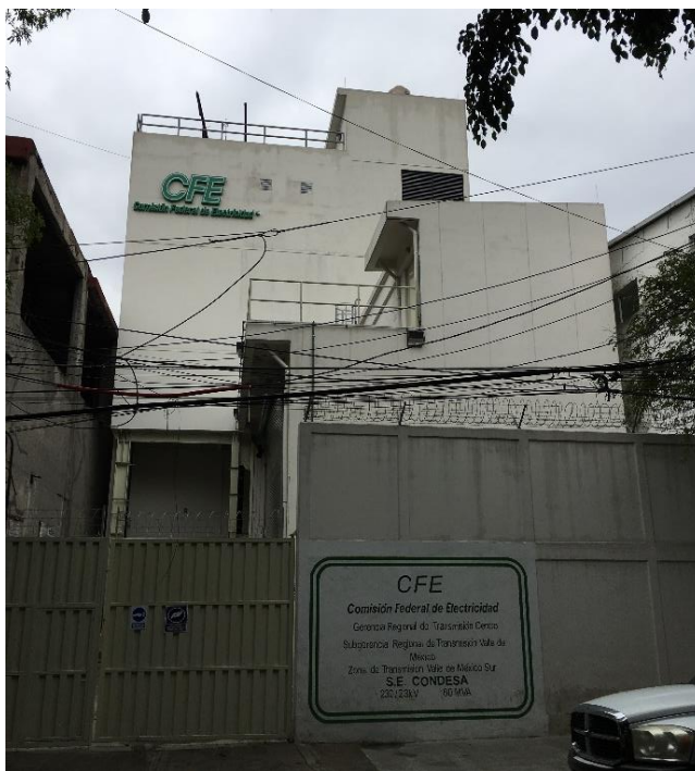
Figura 4.1 Subestación Condesa (CDS) 230/23 kV 60 MVA.
