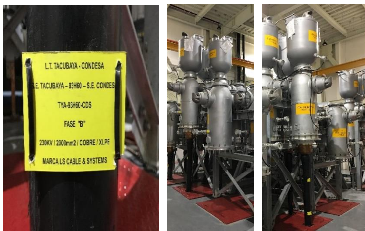
Figura 4.8 Cable de potencia CDS-93H60-TYA.
