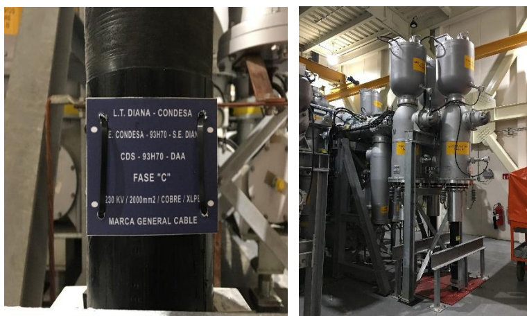
Figura 4.9 Cable de potencia CDS-93H70-DAA.
