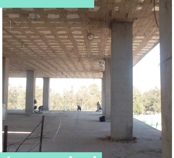
Trabes y losa tercer nivel
