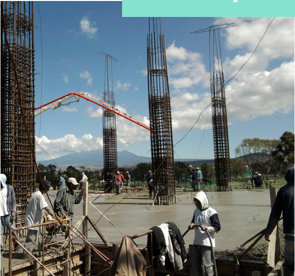
Trabes y losa tercer nivel
