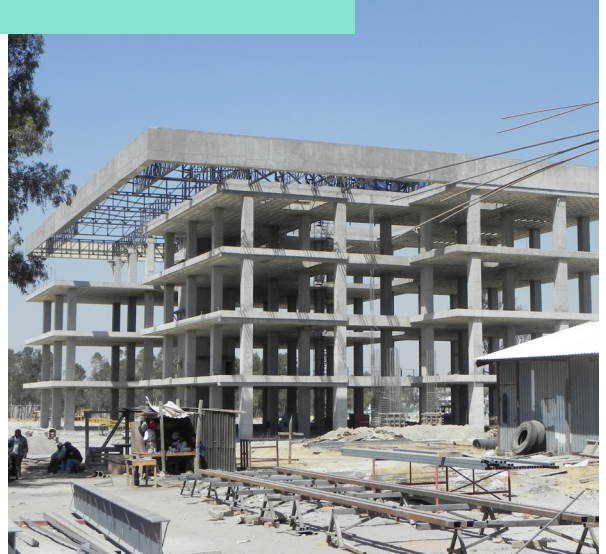
Trabes y losa tercer nivel
