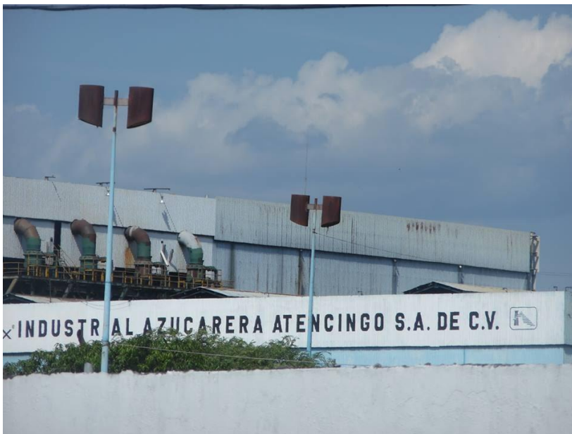
Ilustración 2 Autor: Juan Carlos Rosas, 24/05/2022. Deterioro general de la infraestructura del ingenio de Atencingo.
