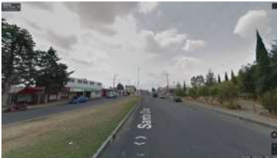
Fotografía 7 Vialidad primaria, carretera Apizaco-Santa Cruz. Foto de Google Street View
