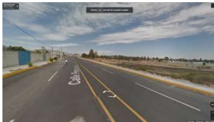
Fotografía 5 Borde: terreno baldío que impide la continuacion de las vialidades en Loma Florida. Foto de Google Street View
