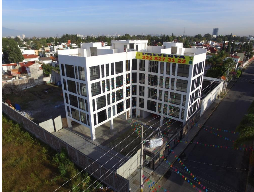
Figura IV.2. Torre 1 (Casas JIE y Asociados).
