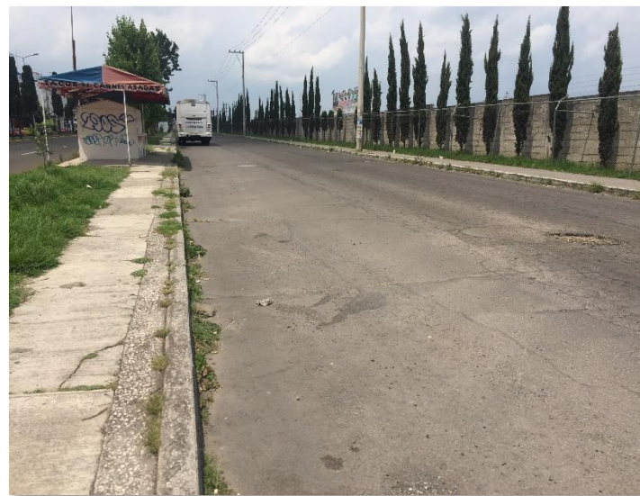
Figura 6. Avenida Xonacatepec donde se muestra el área bardeada, provocando una extensión de vacíos, siendo más peligroso por las noches en cuanto a delincuencia. Fuente: Fotografía autoría propia 2020.
