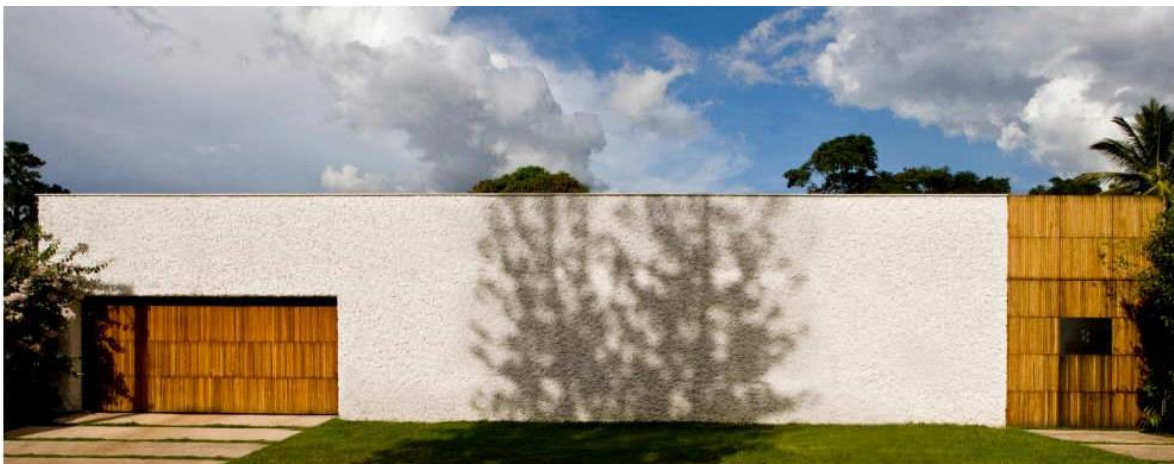
Figura 15 Fachada Principal de Casa 8
