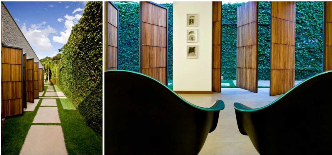
Figura 16 Puertas pivotantes (fachada lateral) creadas con madera certificada
