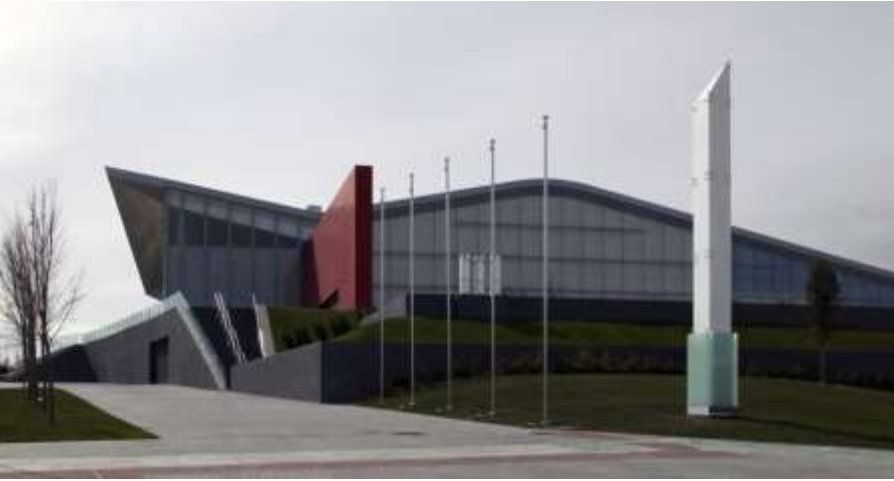
Imagen 67. Centro cultural Miguel Delibes – Fachada durante el día. Fotografía recuperada de http://www.archdaily.mx . Valladolid, España, 2007.
