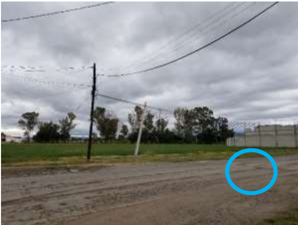
Imagen 41. Carretera Federal San Lorenzo-Tochtepec. Fotografía de Faustino M. Tochtepec, Puebla. 2019 Sobre la carretera principal que pasa frente al terreno destinado a trabajar al igual que las calles que lo rodean cuentan con pozos de visita a cada 60 m.
