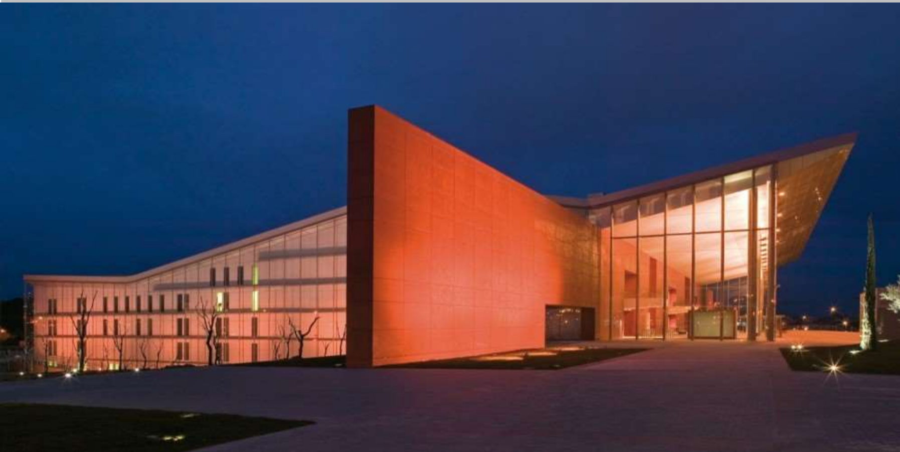
Centro Cultural Miguel, fotografía recuperada de http://www.archdaily.mx . Valladolid, España, 2007.
