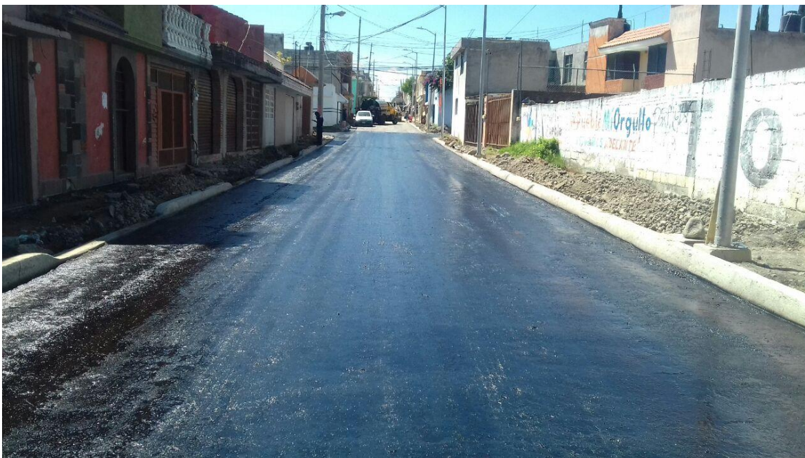
Figura 11. Riego de impregnación, imagen de autoría propia.
