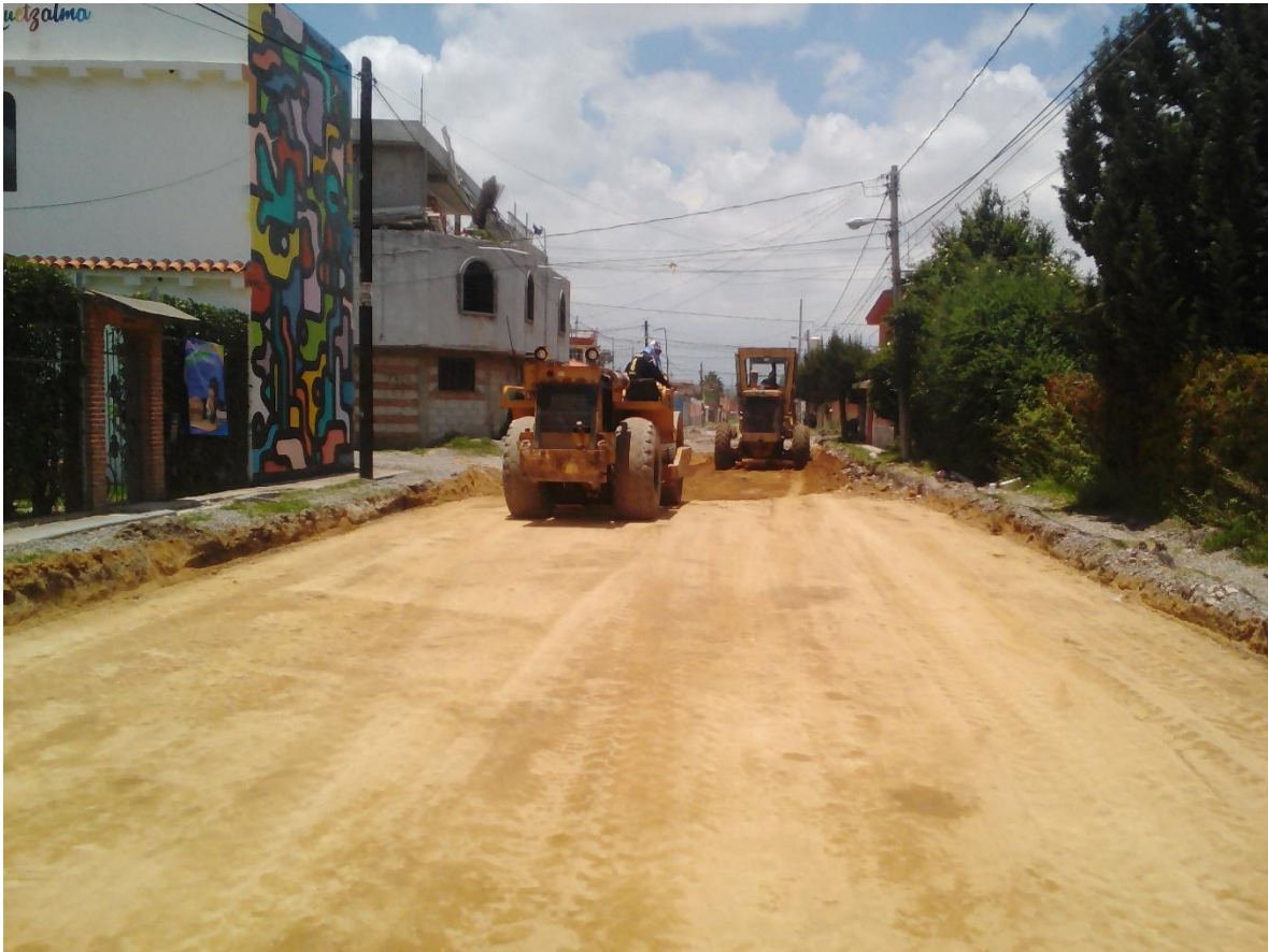
Figura 10. Tendido de material y compactación con rodillo liso, imagen de autoría propia.
