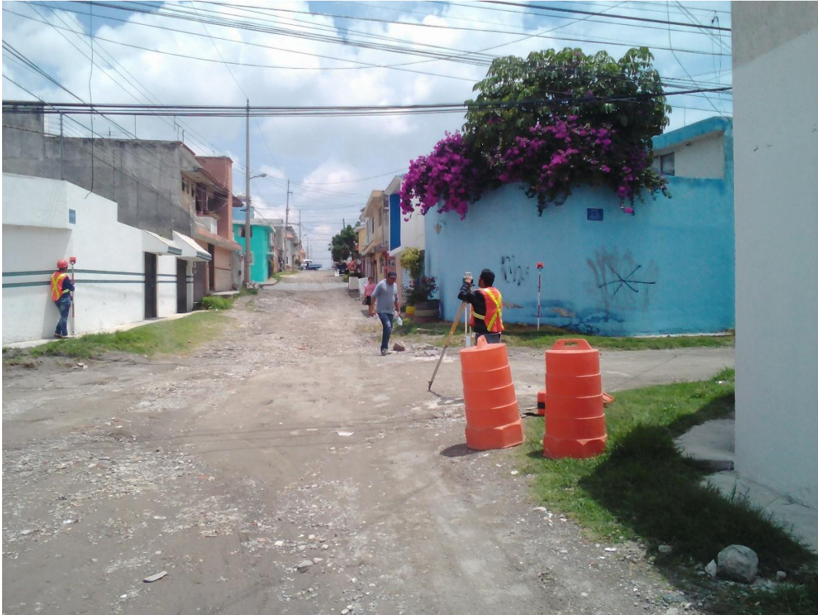
Figura 6. Trabajos de topografía, imagen de autoría propia.
