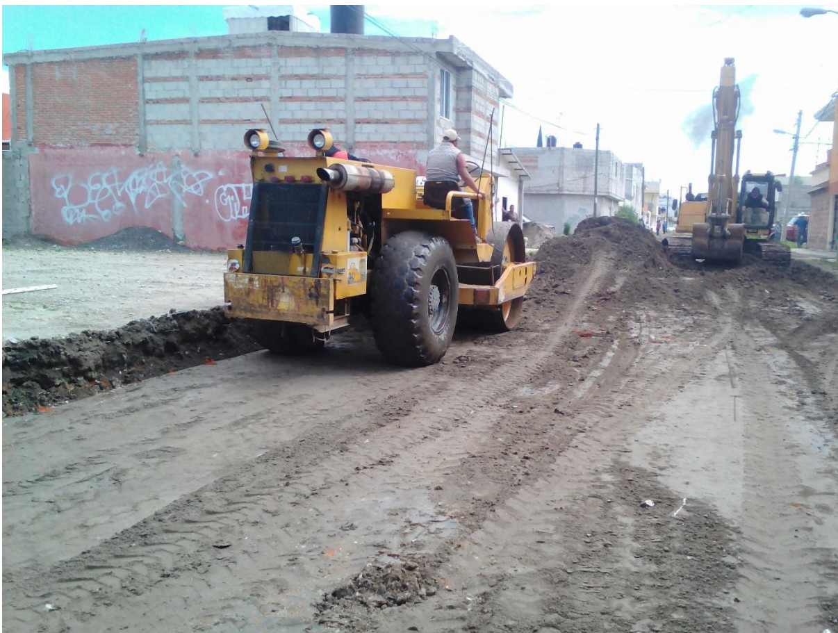
Figura 8. Tendido de material y compactación con rodillo liso, imagen de autoría propia.
