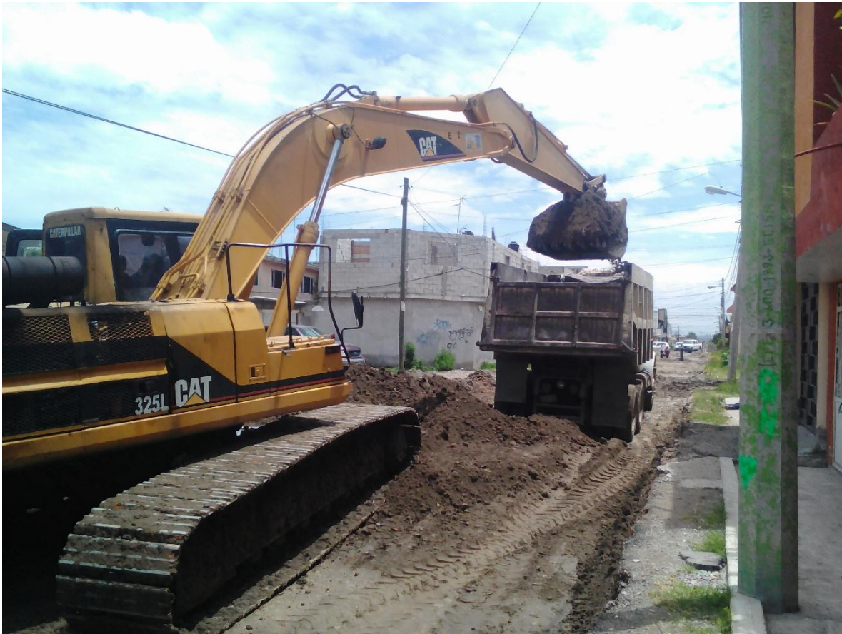
Figura 7. Acarreo de material con volteo, Imagen de autoría propia.
