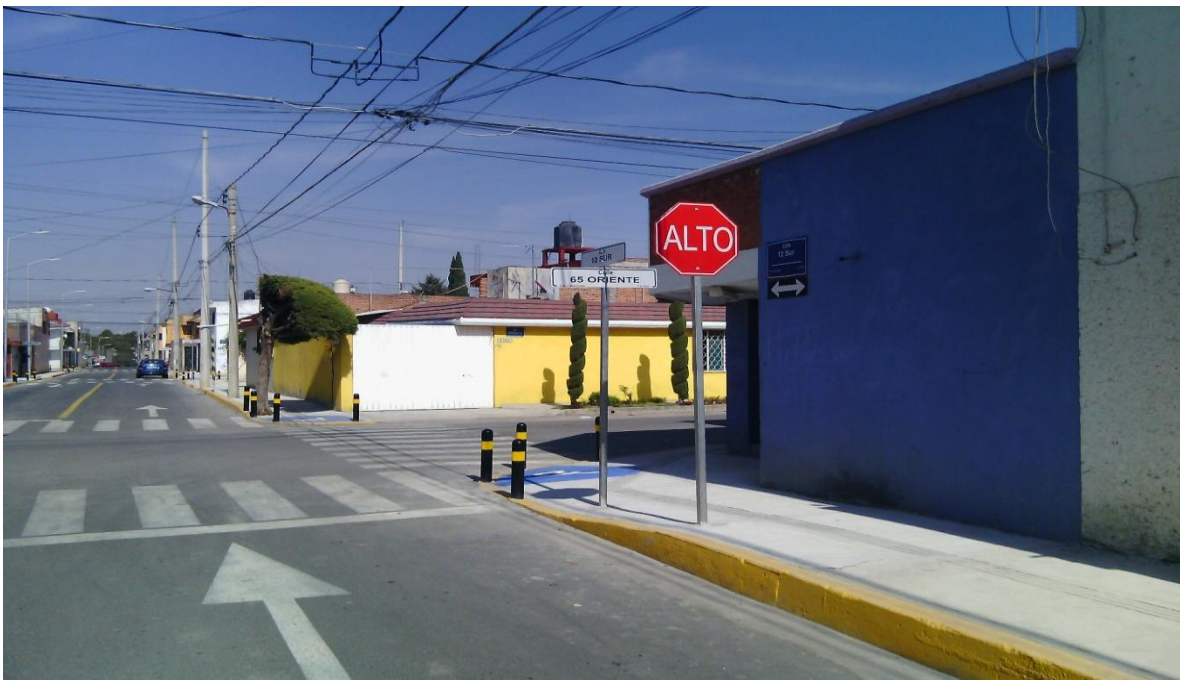
Figura 13. Obra terminada, imagen de autoría propia.
