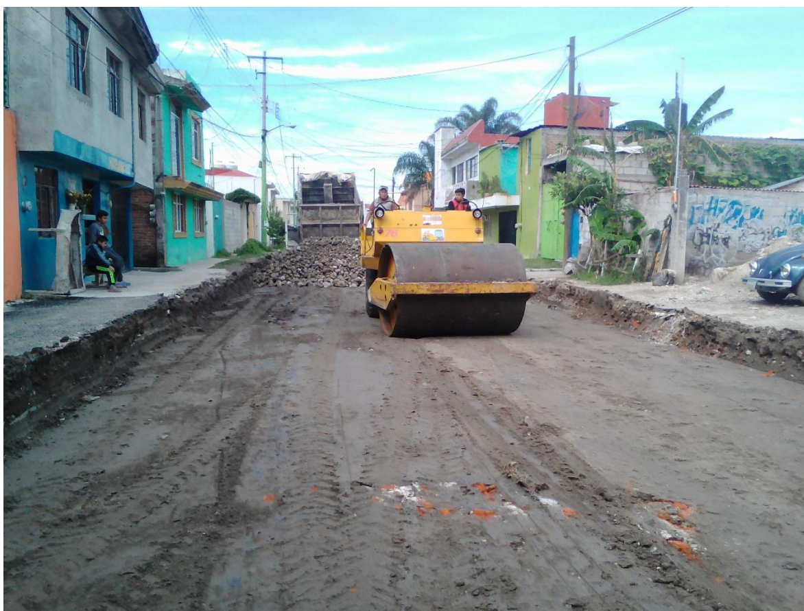
Figura 9. Compactación con rodillo liso, imagen de autoría propia.
