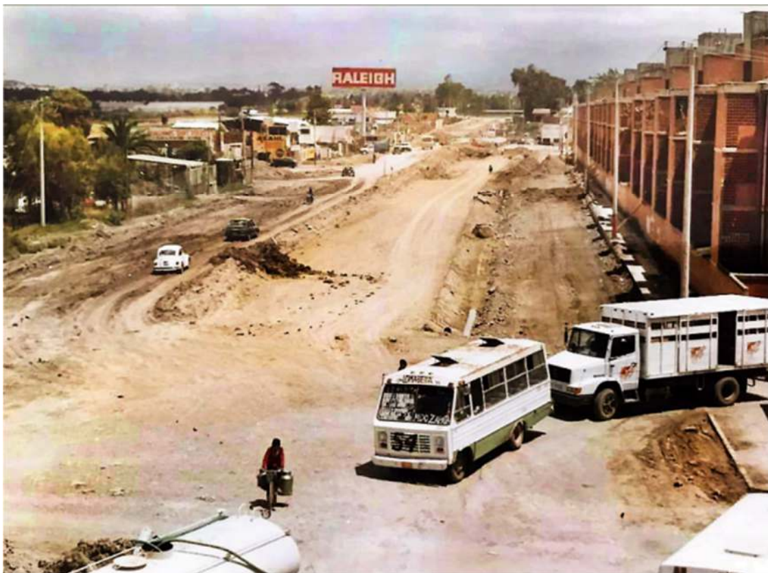
Fig. 10 Se muestra el inicio de la construcción de Periférico Ecológico en el sur de la ciudad de Puebla.
