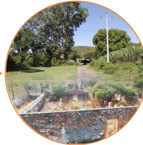
ANTIGUA CASA DE PURGA ACCESO PRINCIPAL/JAGÜEY
