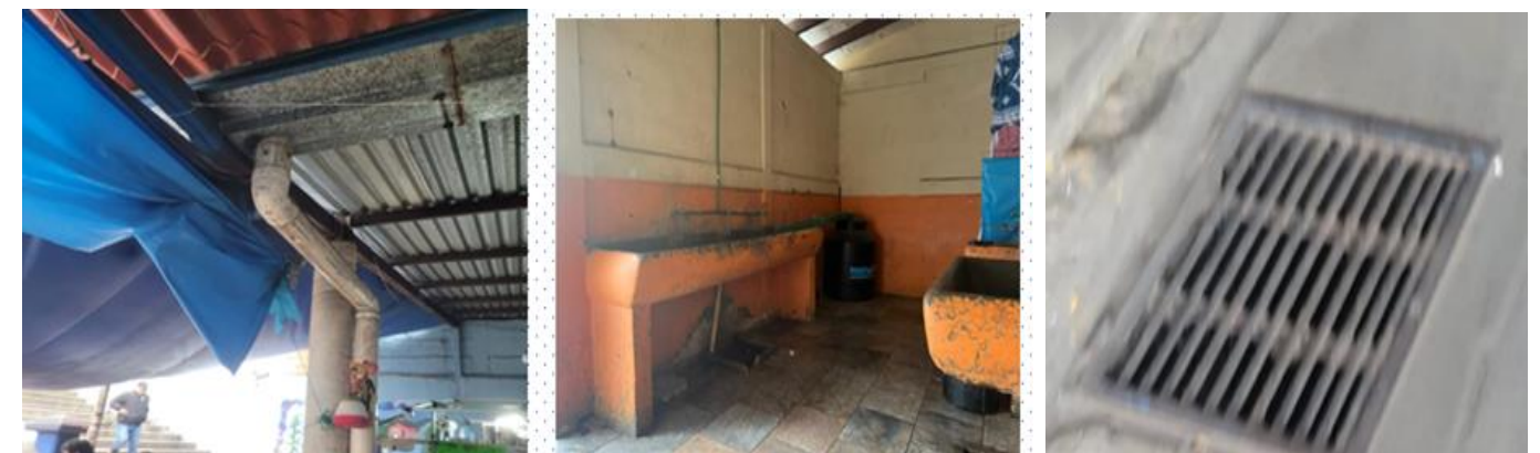
Infraestructura existente foto propia
