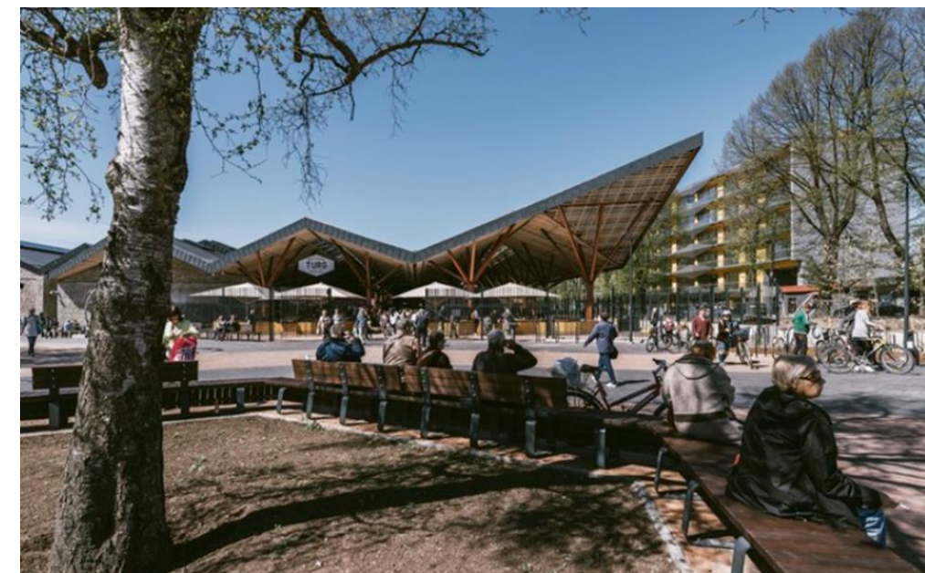
Vista de la cubierta del Mercado y algunas áreas al aire libre Fuente: https://www.archdaily.mx/mx/881936/mercado-estacion-baltica-koko-architects
