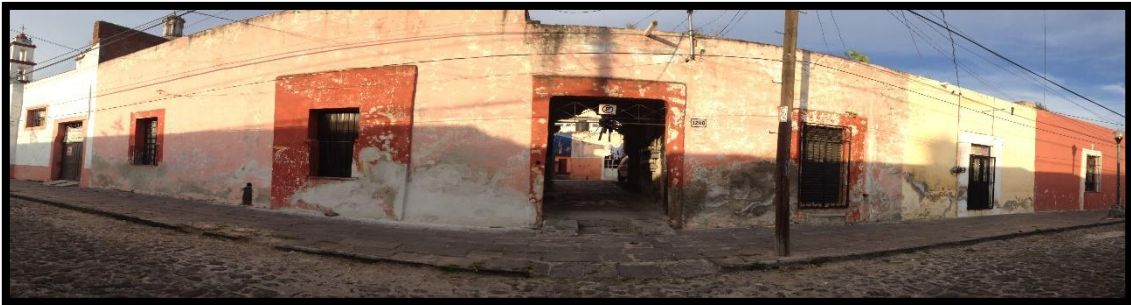
Figura 84 Fachada de la 7 oriente no 1206 barrio del artista Puebla BJB | Fuente Propia 2014
