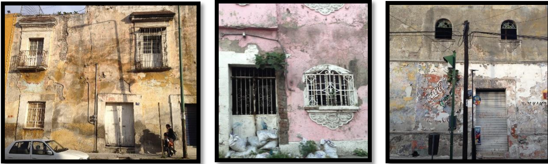
Figura 92,93 y 94 Fachadas en ruinas Esquina de la 8 sur y 9 oriente Barrio de Analco BJB | Puebla. Fuente Propia 2014
