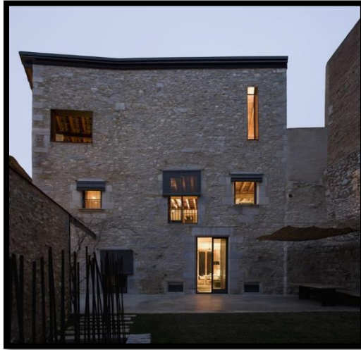
Figura 60 Rehabilitación en Girona/Fachada Poniente del casco Antiguo Hicarquitectura Girona España 2006
