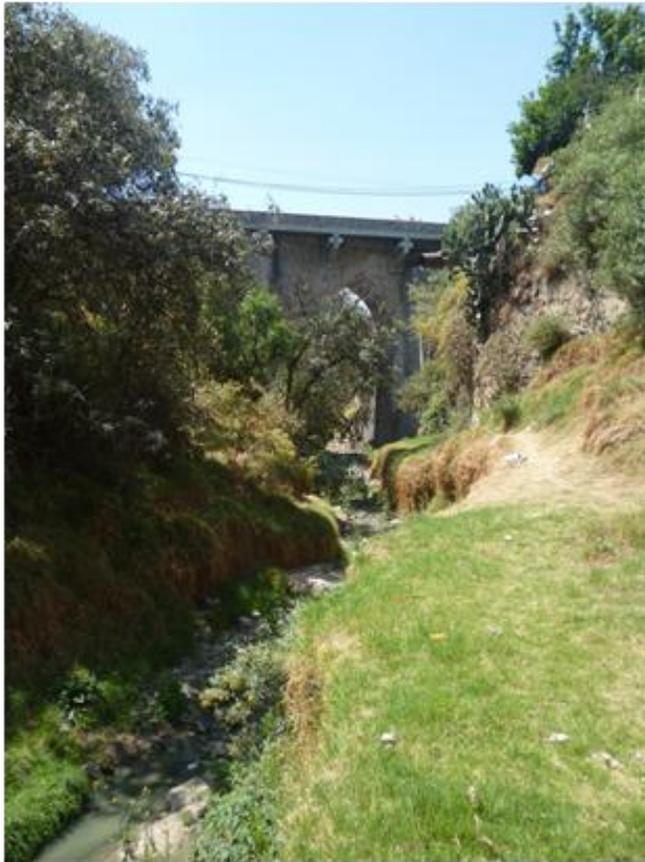
Barranca localizada en el punto 9
