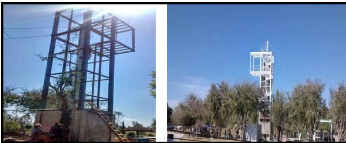
Ilustración 6 montaje y soldado de estructura para tirolesa
