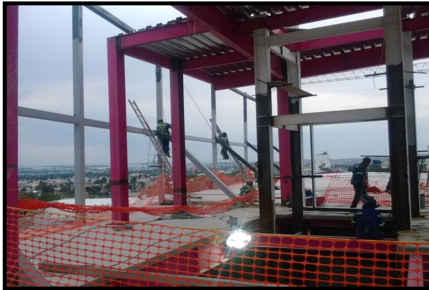
Ilustración 4 ASEGURAMIENTO DE ESCALERA, USO DE EPP CORRESPONDIENTE A ACTIVIDAD DE PINTURA EN PRETIL DE FACHADA; LIVERPOOL GALERIAS SERDAN.
