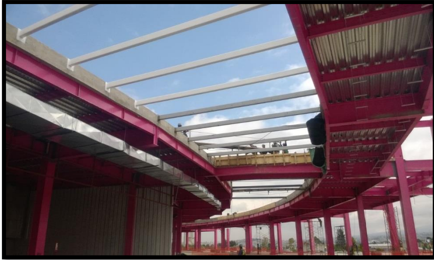
Ilustración 5 USO CORRESPONDIENTE A ACTIVIDAD DE MONTAJE SOLDADO DE LARGUEROS PARA DOMO,
