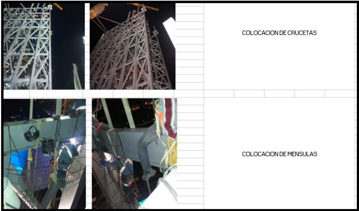
Ilustración 11 REPORTE FOTOGRAFICO DE MONTAJE ENTREGADO A CONTRALORIA OBRA TELEFERICO ESTACION EXPOSITOR
