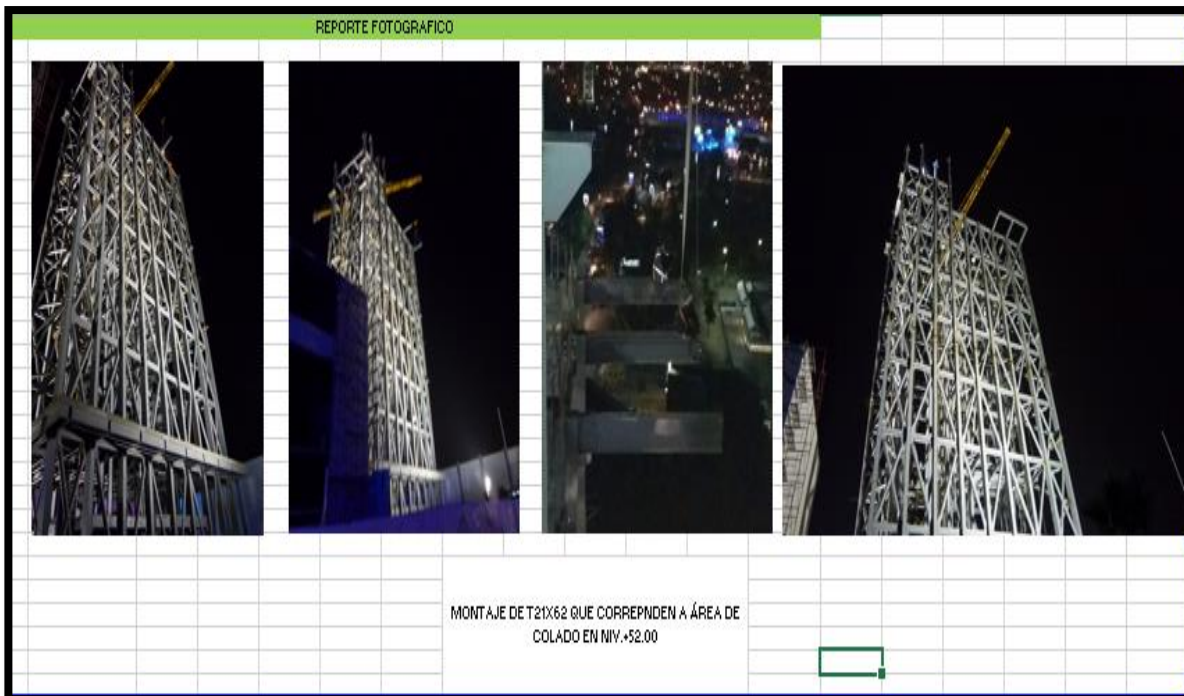
Ilustración 10 reporte fotográfico presentado a contraloría del montaje de estructura, teleférico estación expositor
