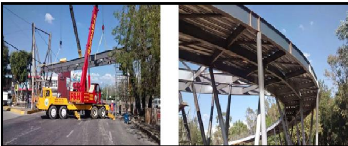
Ilustración 7 montaje y soldado de ciclo pista que conecta de la Av. 31 Pte. al Parque Revolución Mexicana
