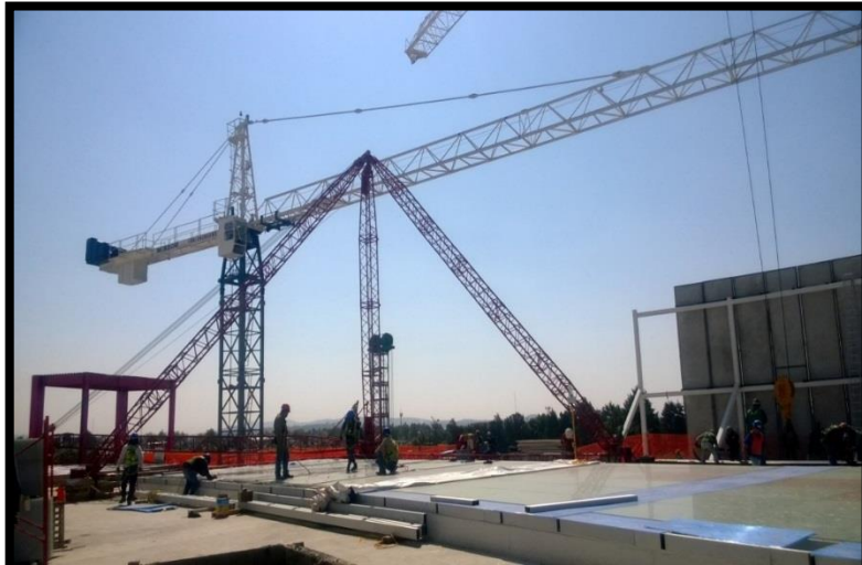
Ilustración 1 ARMADO DE TORRE GRÚA EN LIVERPOOL, GALERÍAS SERDÁN
