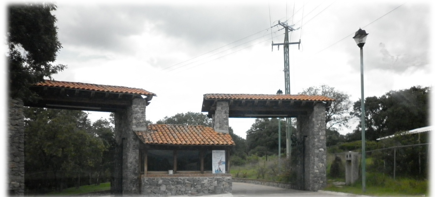
Ilustración 37 – Caseta de vigilancia, en acceso a la Finca Los Alamos.
