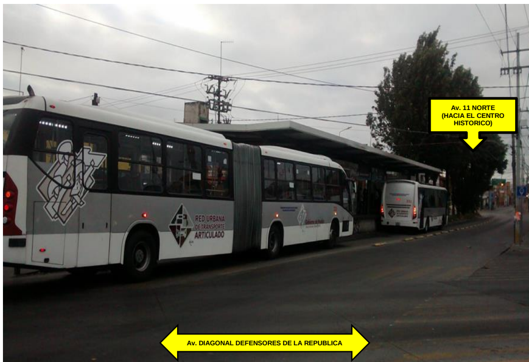
Imagen No. 85.- Estación: “Diagonal Poniente”, (vista hacia el Sur).
