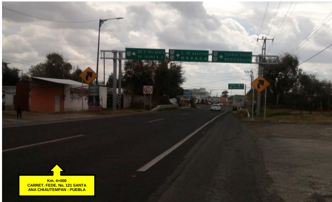
Imagen No. 143.- km. 4+000, con sentido a Puebla, (Vista hacia el Sur)
