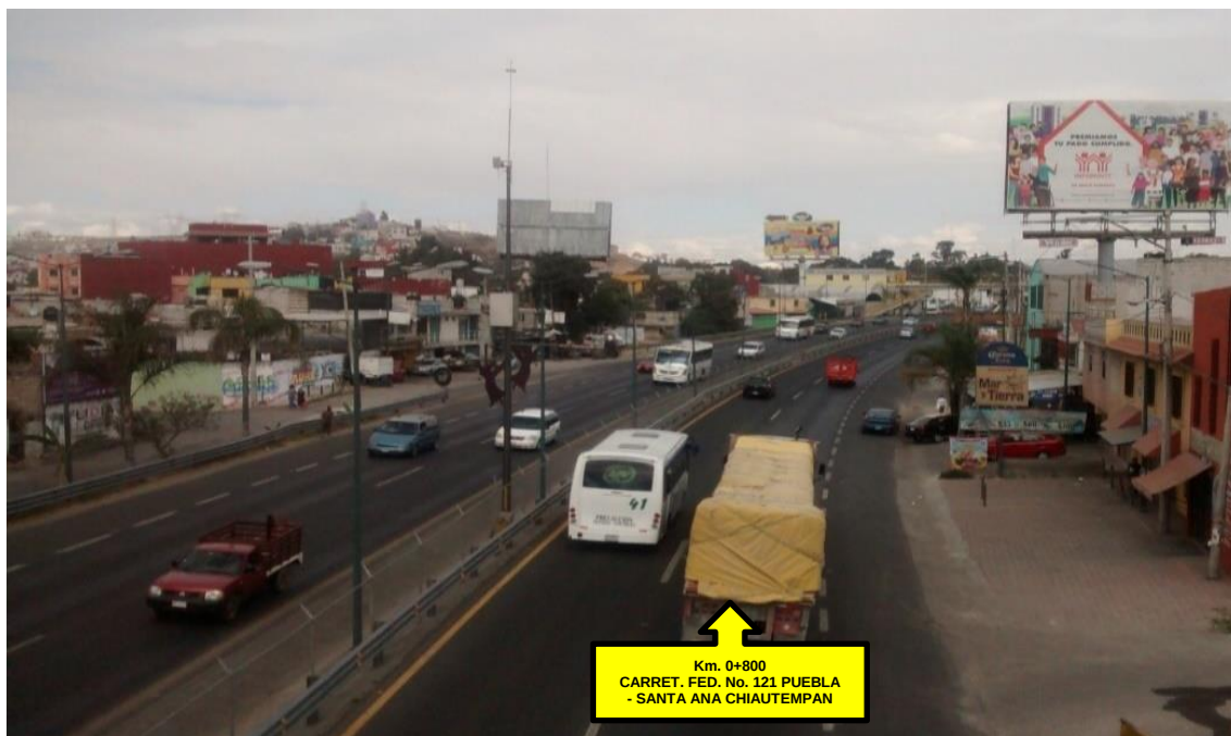
Imagen No. 125.- Km. 0+800, con sentido a Santa Ana Chiautempan, (Vista hacia el Norte)
