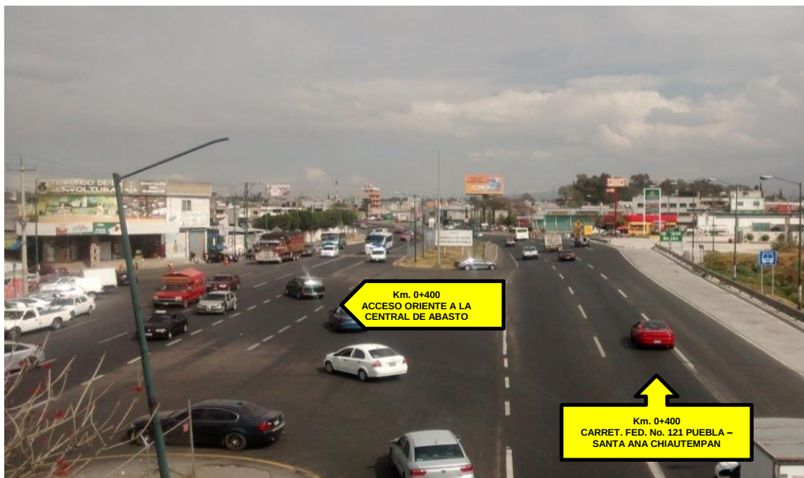
Imagen No. 122.- Km. 0+400, con sentido a Santa Ana Chiautempan, (Vista hacia el Norte)
