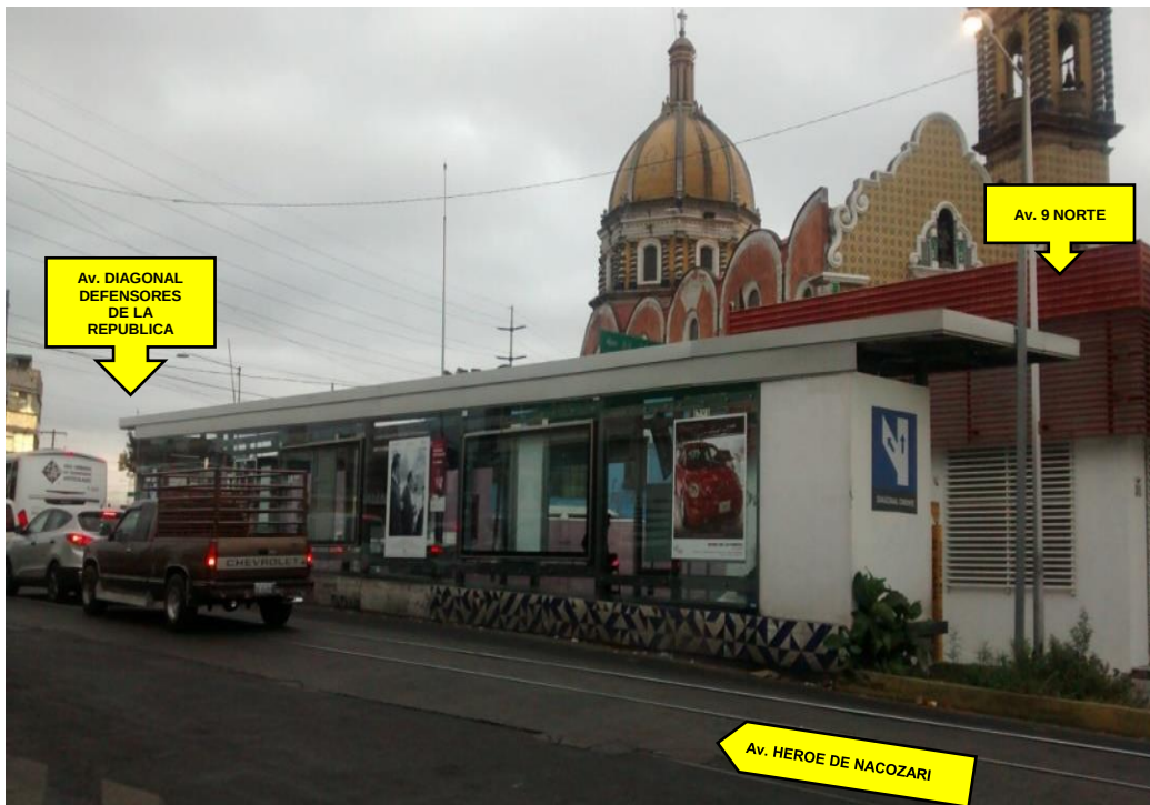
Imagen No. 94.- Estación: “Diagonal Oriente”, (vista hacia el Poniente).
