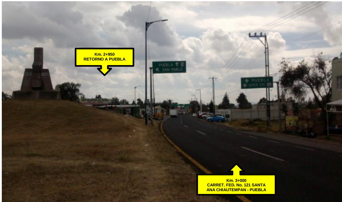
Imagen No. 142.- km. 3+000, retorno con sentido a Puebla, (Vista hacia el Sur)
