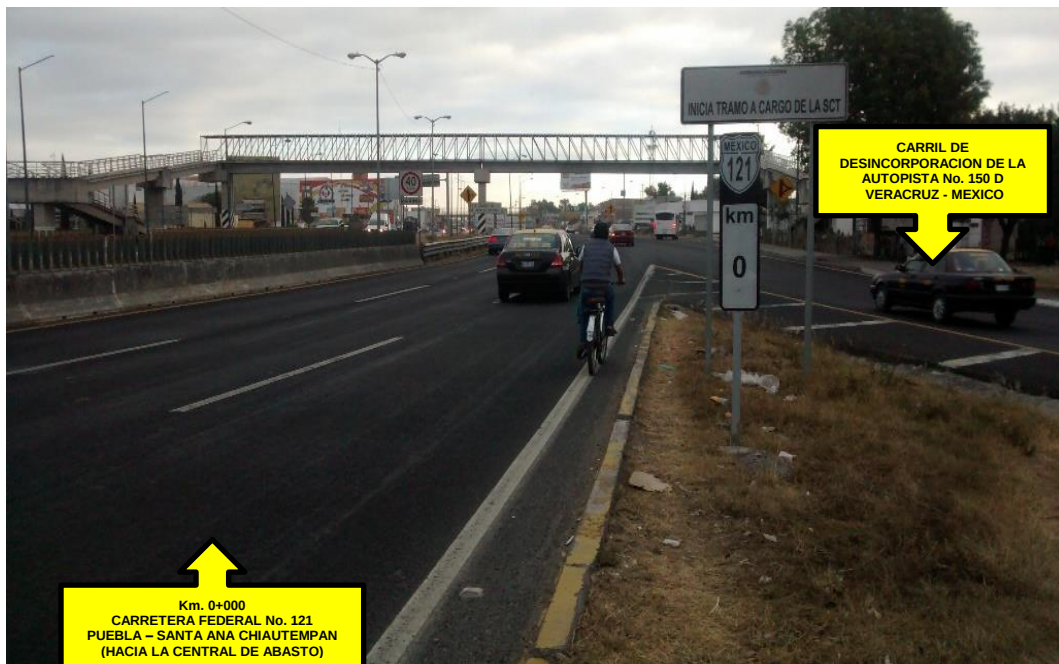
Imagen No. 109.- Km. 0+000 Carretera Federal No. 121 Puebla – Santa Ana Chiautempan (Vista hacia el norte)
