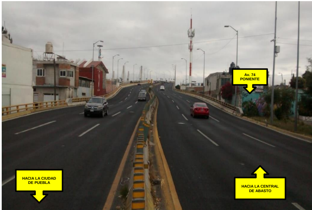
Imagen No. 74.- Inicia Distribuidor Vial Santa Ana (vista hacia el Norte).
