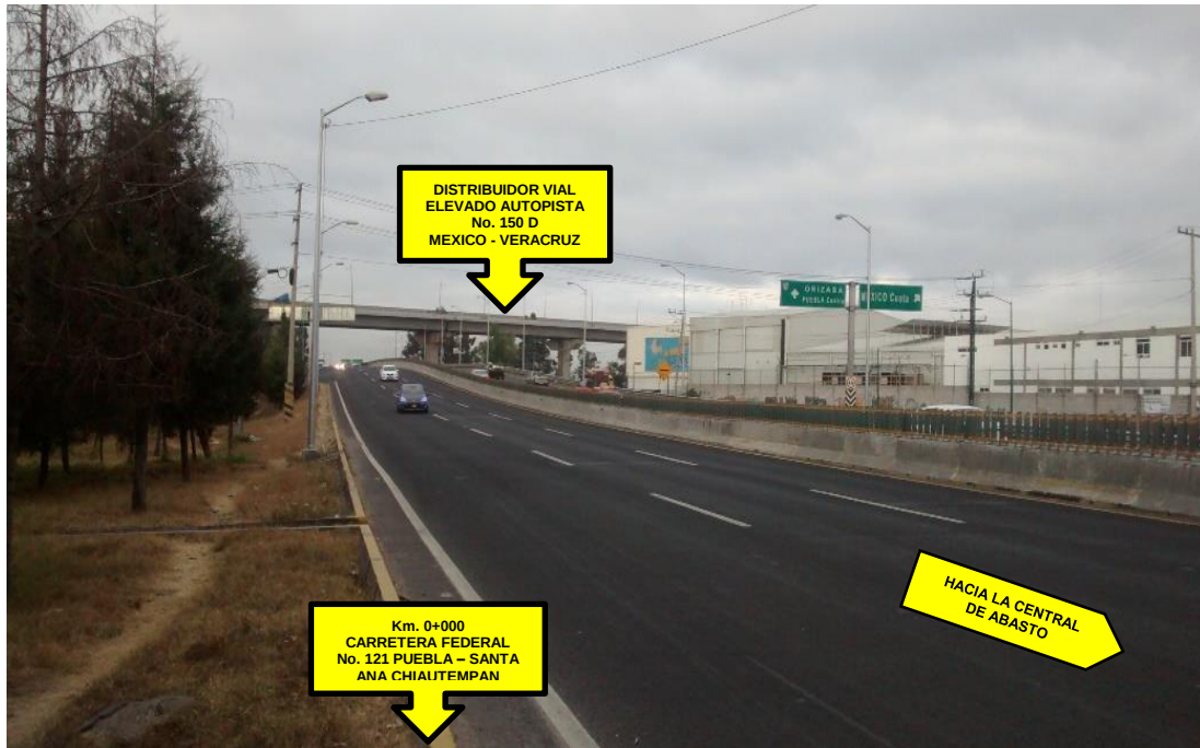
Imagen No. 106.- Termina el trayecto del Distribuidor Vial Santa Ana (vista hacia el Sur)
