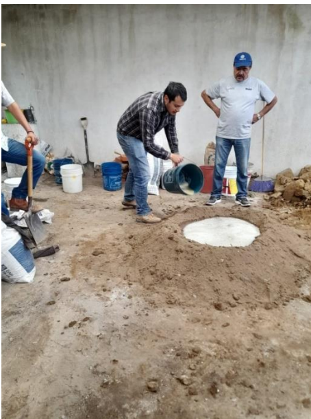
Fig. 25. Agua de nejayote en la mezcla
