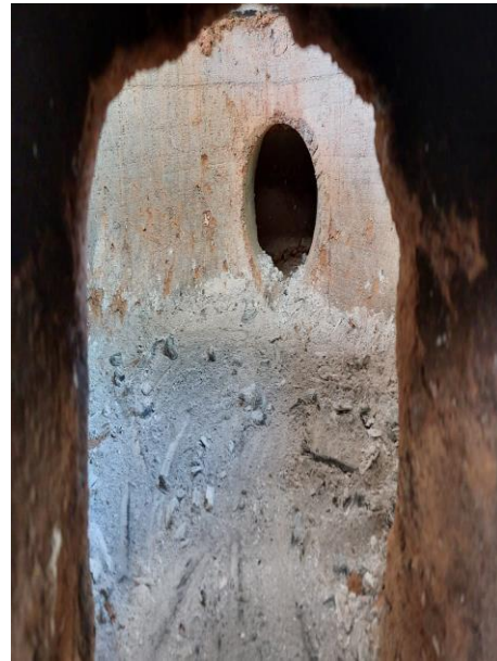
Fig. 90. Acabado final de los ductos
