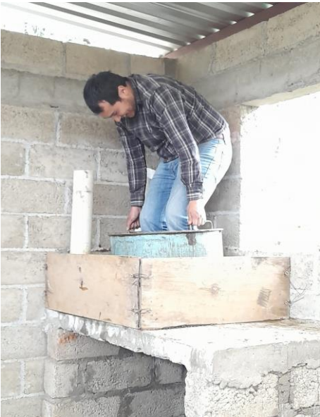
Fig. 41. Extracción del molde de la estufa
