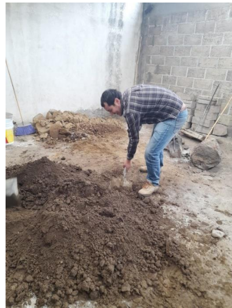
Fig. 32. Mezcla homogénea
