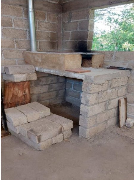
Fig. 87. Acabado final de la estufa
