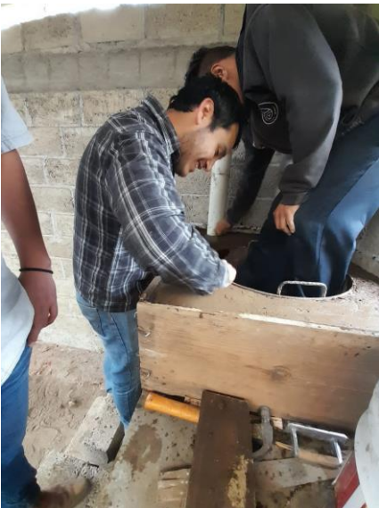
Fig. 39. Aplanado de la mezcla
