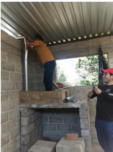
Fig. 45. Colocación de la tubería de salida
