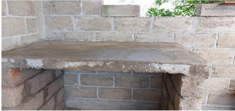
Fig. 18. Base de cemento o tlecuil.
