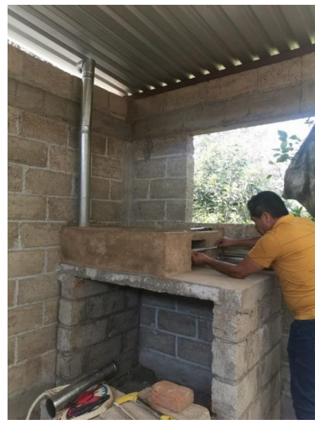
Fig. 46. colocación final de tubería
