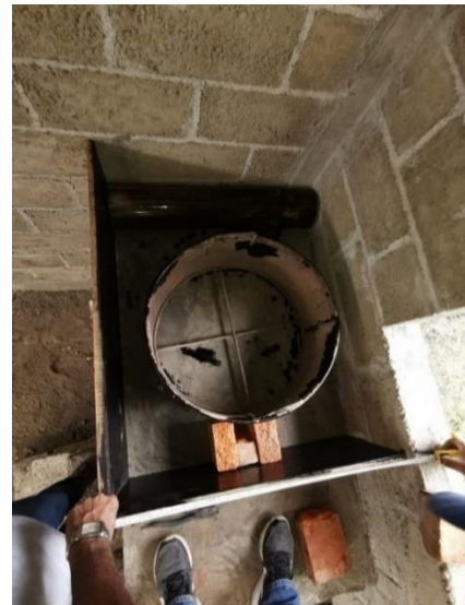
Fig. 36. Colocación de los tubos
