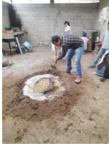
Fig. 28. Mezcla de afuera hacia adentro
