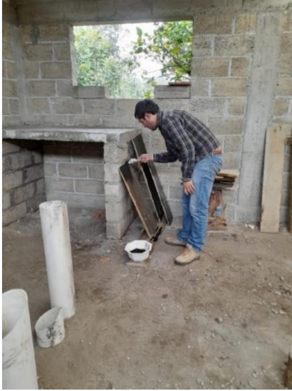
Fig. 29. Moldes engrasados con aceite
