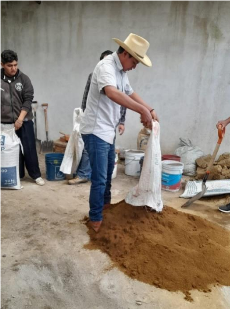
Fig. 21. Vaciado de materiales
