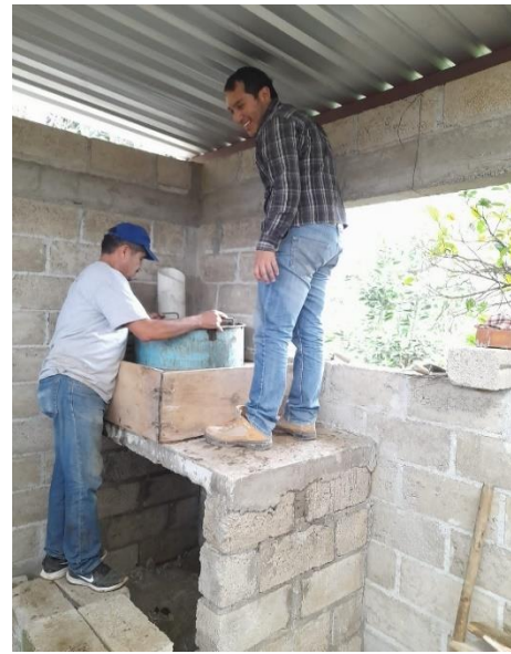
Fig. 42. Extracción final del molde
