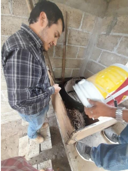
Fig. 37 Relleno de mezcla en el cajón
