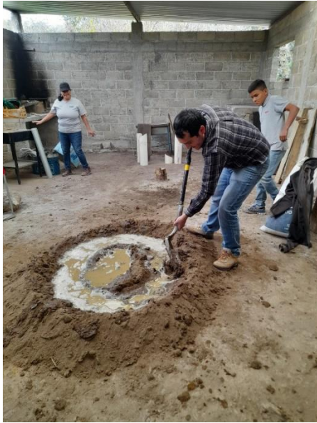
Fig. 27. Mezcla de los materiales con el agua
