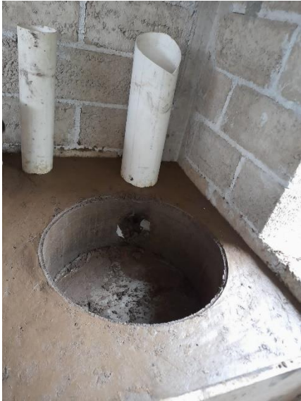
Fig. 43. Vista de la cámara de combustión
