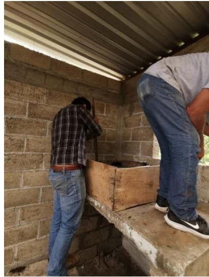
Fig. 38. Compactación de la mezcla
