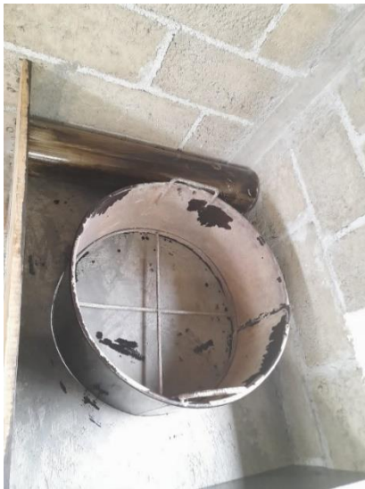
Fig. 35. Colocación del molde
