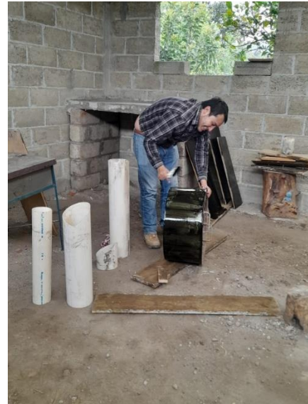
Fig. 30. Moldes para construir una estufa.
