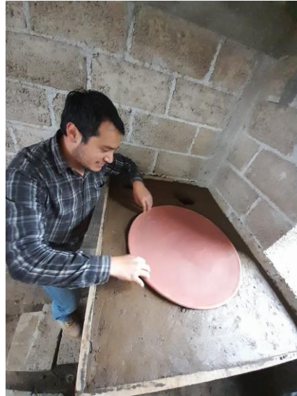
Fig. 44. Colocación del comal de barro
