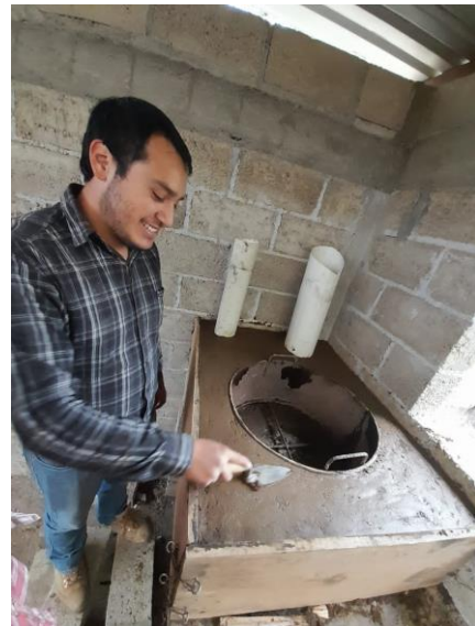
Fig. 40. Retocado de la mezcla
