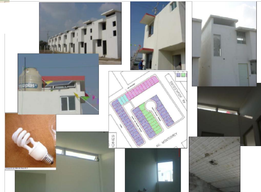
6.- Vivienda de Interés Social IVNL (Instituto de la Vivienda de Nuevo León) 16
