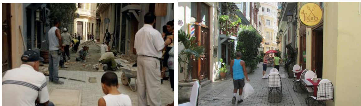
Figura 14 Rehabilitación de la Calle Aguiar/ Estado Actual Fuente: Cuaderno Informativo de ARTECORTE, 2019; Pinterest, 2022
