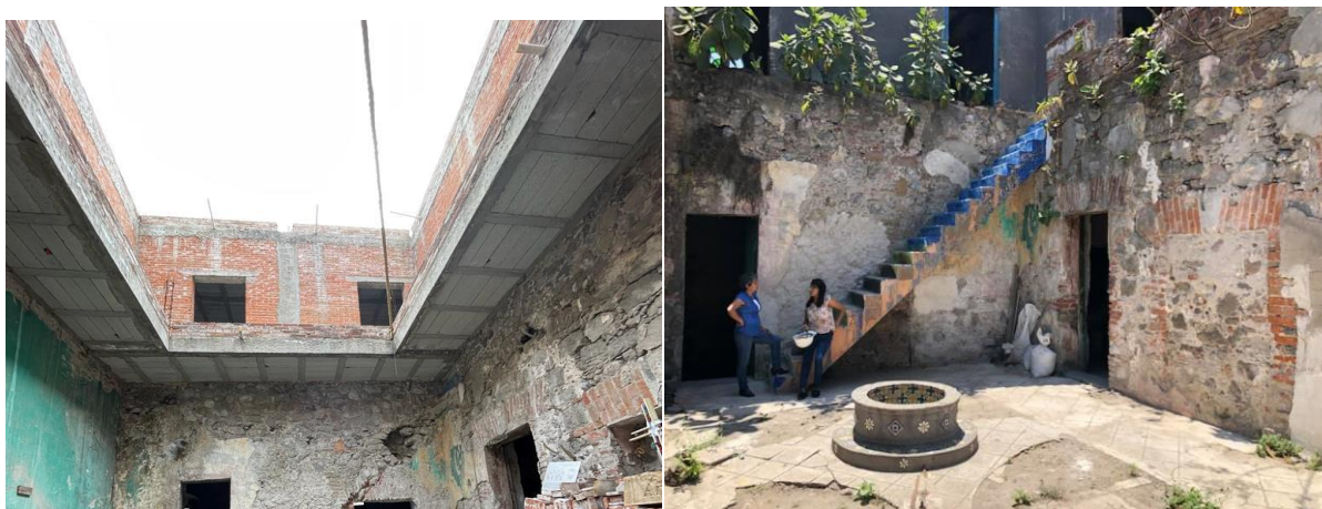
Figura 12 Foto A es el Estado actual de Casa Analco, la fotografía B se muestra como era en el 2018 Fuente: Fotografía Propia 2022 y Fotografía tomada de Galería digital de Casa Analco (2018)
