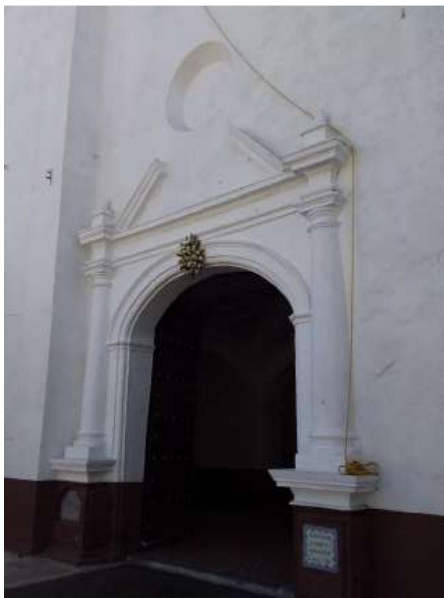
Figura I.20. Portada de la iglesia conventual de Amozoc. Fuente: Acervo fotográfico de PAS, Amozoc, Pue., a 08 de abril de 2021.
