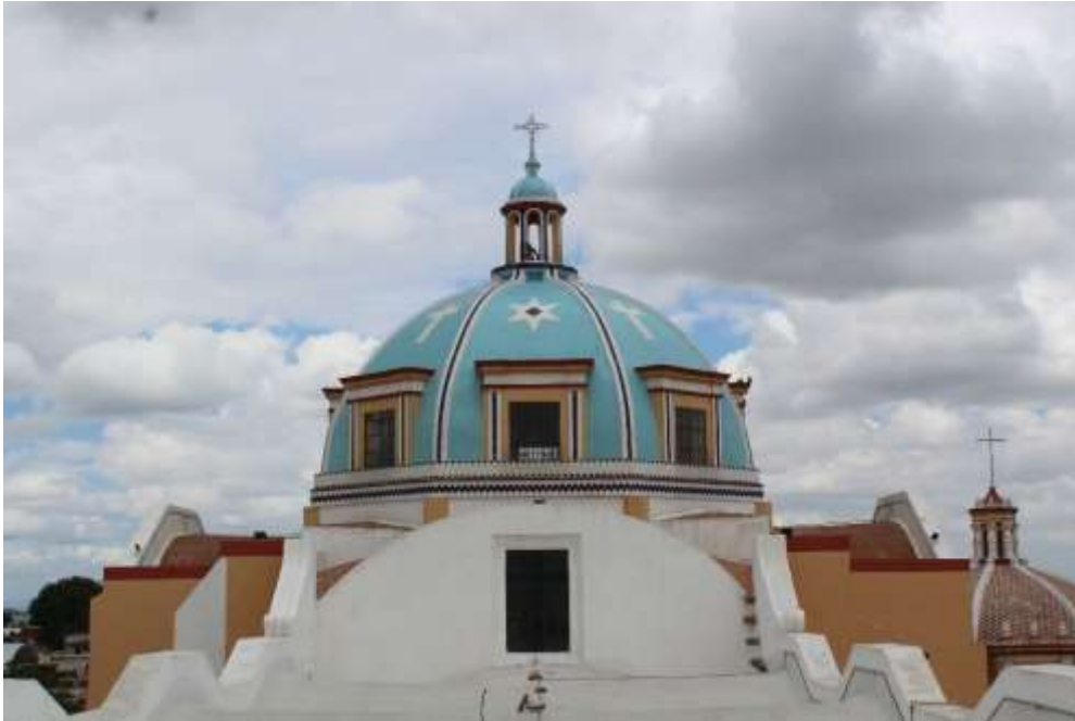
Figura II.17. Cúpula de la iglesia parroquial de Amozoc. Fuente: Acervo fotográfico de PAS, Amozoc, Pue., a 02 de agosto de 2022.
