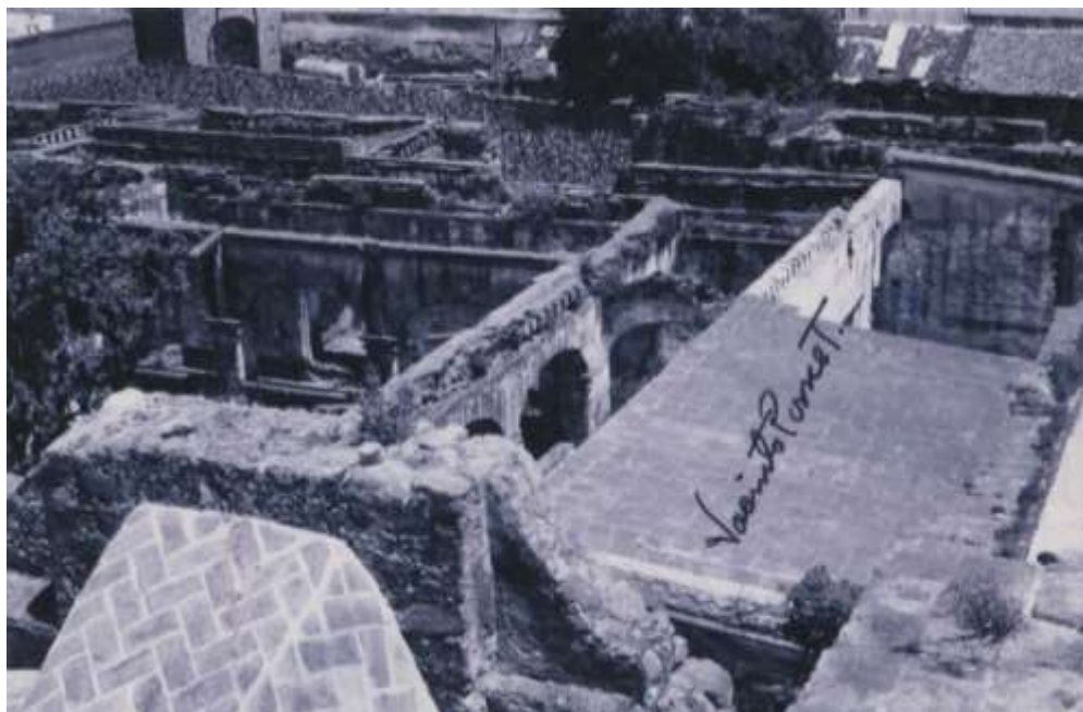
Figura II.10. Restos de la cubierta del claustro alto del convento de Amozoc. Fuente: Acervo fotográfico de J. Jacinto Alberto Ponce Torres, Amozoc, Pue., aprox. década de 1970.
