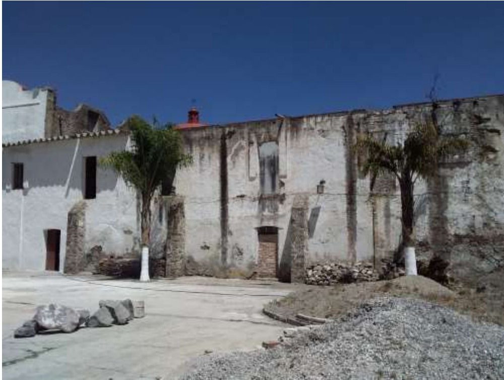
Figura I.14. Antiguo portal de peregrinos del claustro de Amozoc. Fuente: Acervo fotográfico de PAS, Amozoc, Pue., a 24 de marzo de 2021.
