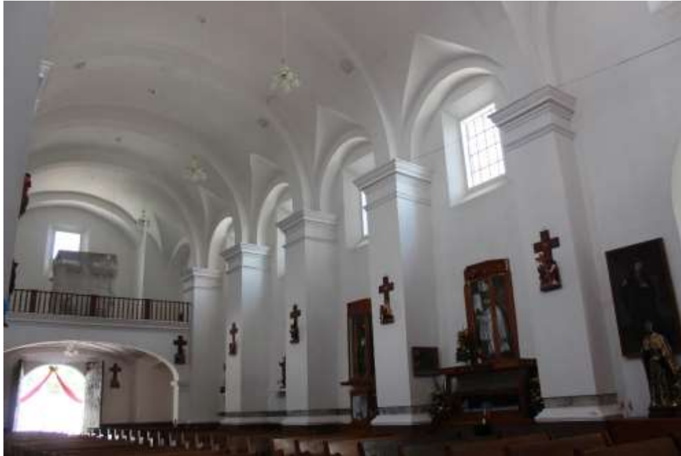
Figura II.3. Contrafuertes internos de la iglesia conventual de Amozoc. Fuente: Acervo fotográfico de PAS, Amozoc, Pue., a 02 de julio de 2022.
