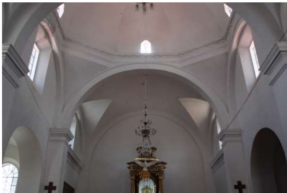
Figura II.6. Pechinas y arcos torales de la iglesia conventual de Amozoc. Fuente: Acervo fotográfico de PAS, Amozoc, Pue., a 02 de julio de 2022.
