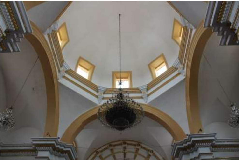
Figura II.18. Pechinas y arcos torales de la iglesia parroquial de Amozoc. Fuente: Acervo fotográfico de PAS, Amozoc, Pue., a 03 de septiembre de 2022.
