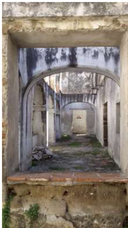
Figura I.10. Corredor sur del claustro conventual de Amozoc. Fuente: Acervo fotográfico de PAS, Amozoc, Pue., a 16 de noviembre de 2020.
