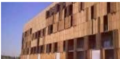
Fig. 24 Aplicación de la madera en edificio Palomino, 2012
