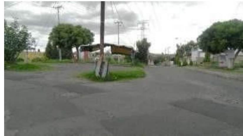
Fig. 48 Av. Torrecillas sin algún tipo de señalización para conductores o peatones Valdez&Ramirez, 2017
