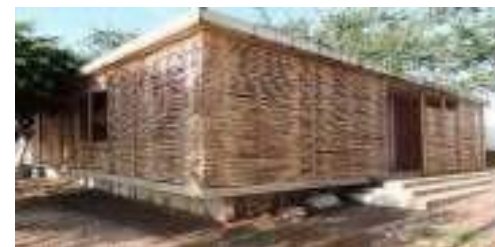
Fig. 26 Carrizo como elemento sismo resistente Enlace Arquitectura, 2017
