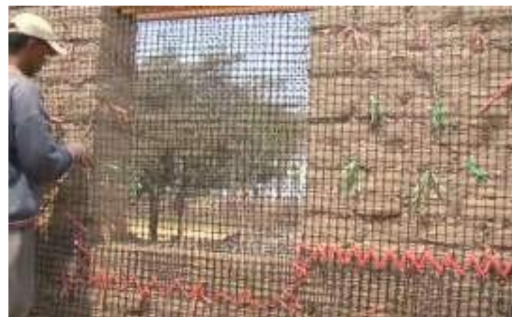
Fig. 38 Malla fijada con cintas de agua Blondet, 2015
