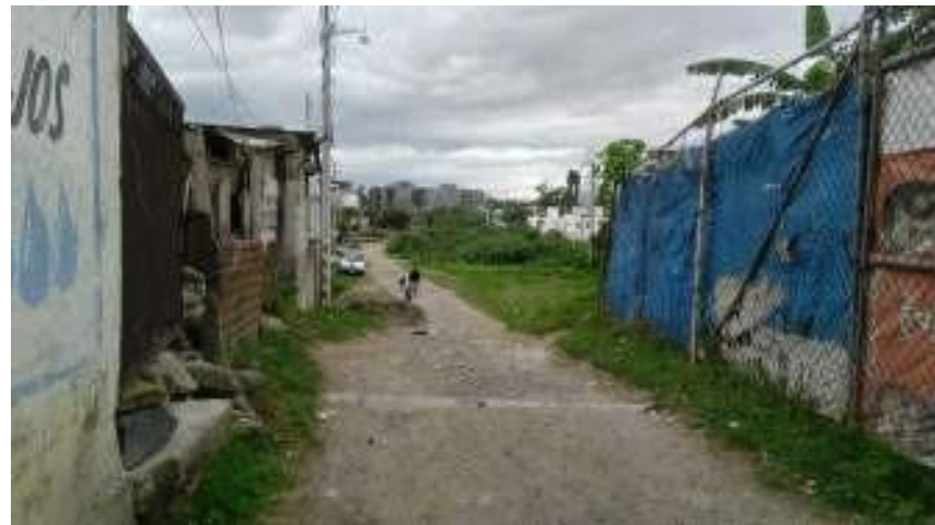
Fig. 45 Calle paralela a Revolución Poniente afectada por inundaciones Valdez&Ramirez, 2017
