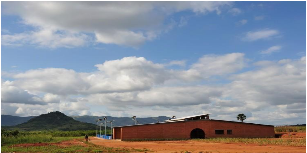
Ilustración 9. (Alina & Carneiro, 2013). Fachada Principal.
