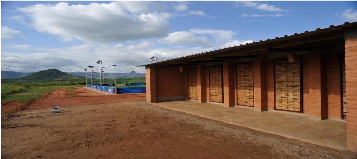
Ilustración 11. (Alina & Carneiro, 2013). Fachada Lateral.
