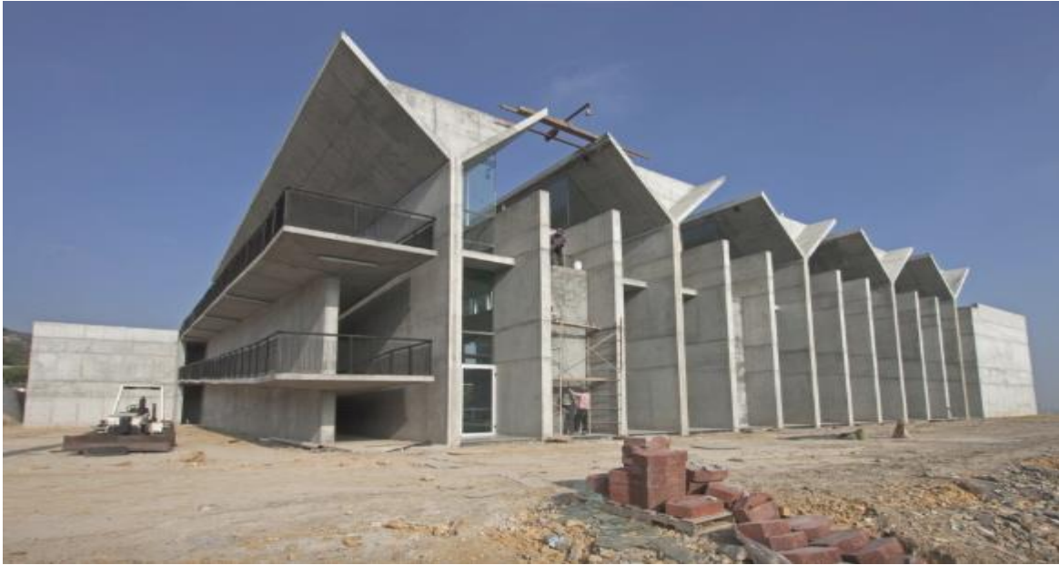
Ilustración 18. (Agustin Landa & Cátedra Blanca Workshop, 2011) Obra Centro Comunitario Independencia. Recuperado https://www.archdaily.mx/mx/02-120997/centro-comunitario-independencia-agustin-landa-catedra-blanca-workshop
