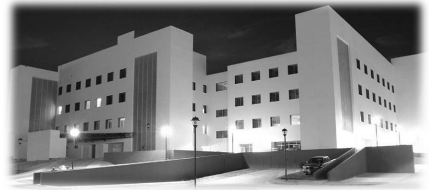
IMAGEN No.09 MUESTRA LA FACHADA DE UN HOSPITAL GENERAL (AGUILAR, 2011)
