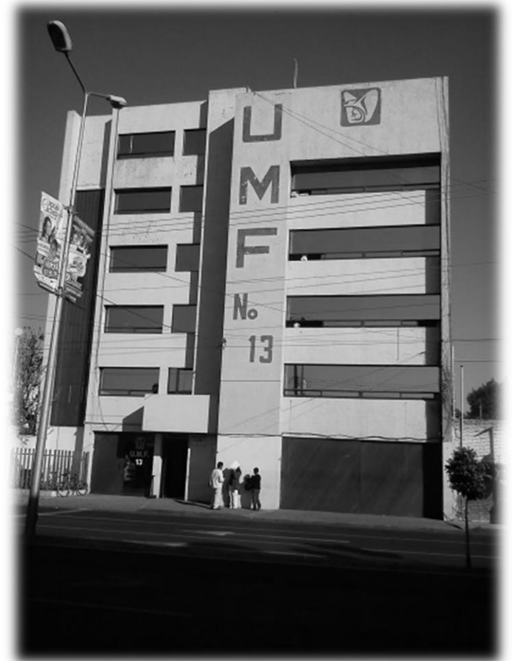
FOTOFRAFIA No. 04 17/04/2013 TOMADA POR JFRJ VISTA LATERAL U.M.F. No. 13
