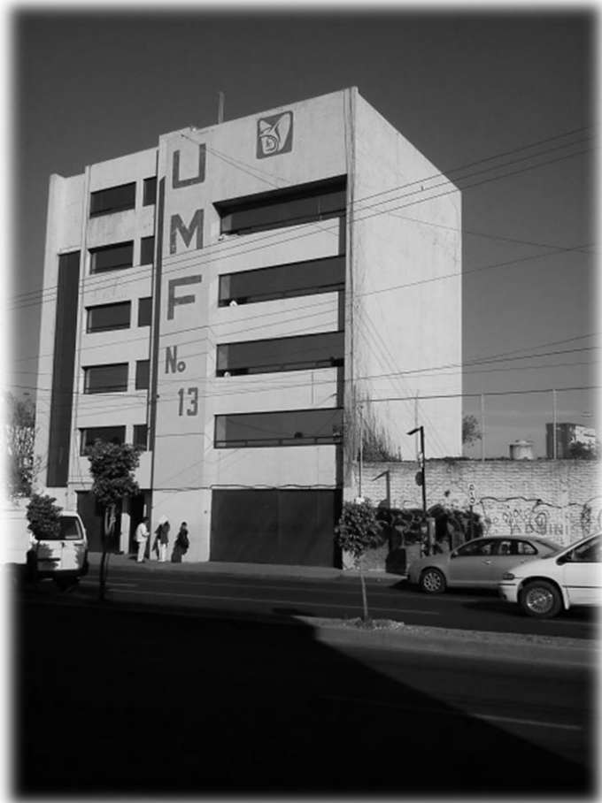
FOTOFRAFIA No. 03 17/04/2013 TOMADA POR JFRJ VISTA LATERAL U.M.F. No.13
