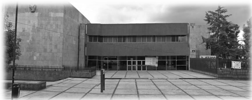
FOTOFRAFIA No. 11 TOMADA POR JFRJ 17/04/2013 FACHADA PRINCIPAL U.M.F. No. 02
