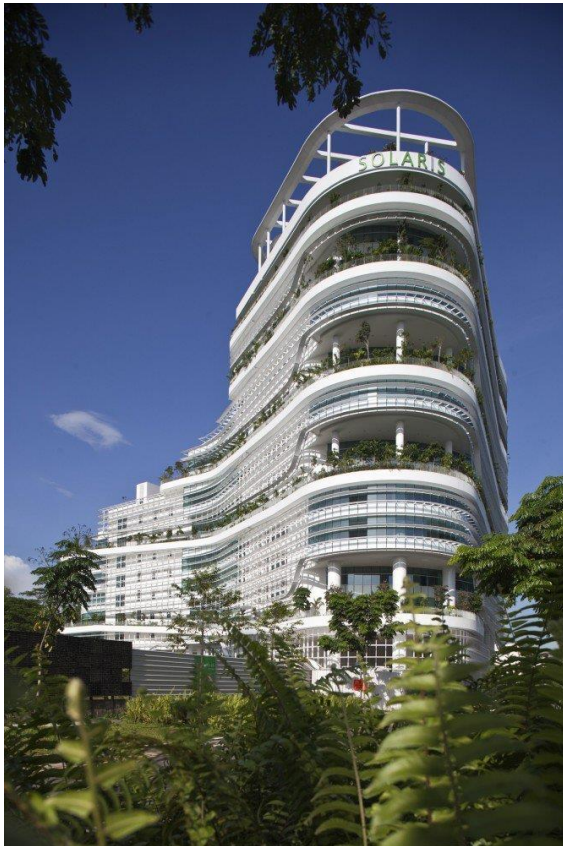
Imagen 61. Edificio Solaris, Singapur. Recuperado de ARQZON.
