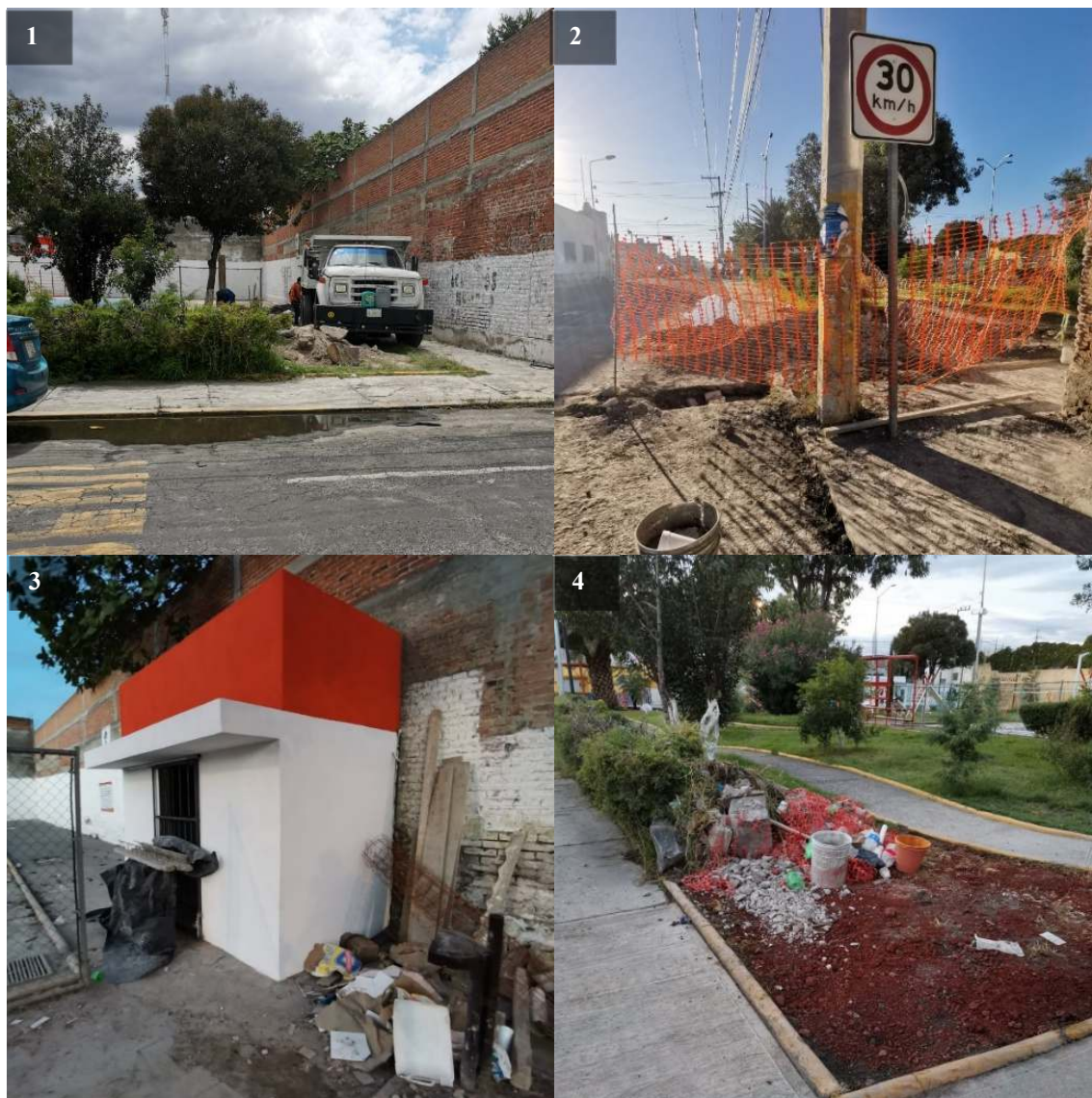
Figura 18. Problemas y situaciones complejas en la construcción del baño al interior del parque Morelos
