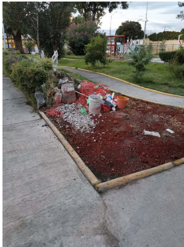
Escombros resultante de la obra del baño. López, 2021. Fotografía digital.
