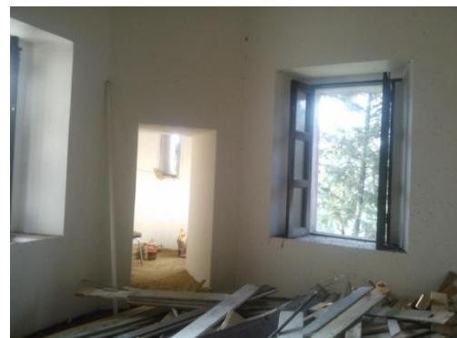
2.-Habitación de planta baja de la hacienda, utilizada como lugar para guardar desperdicio de trabajos anteriores.
