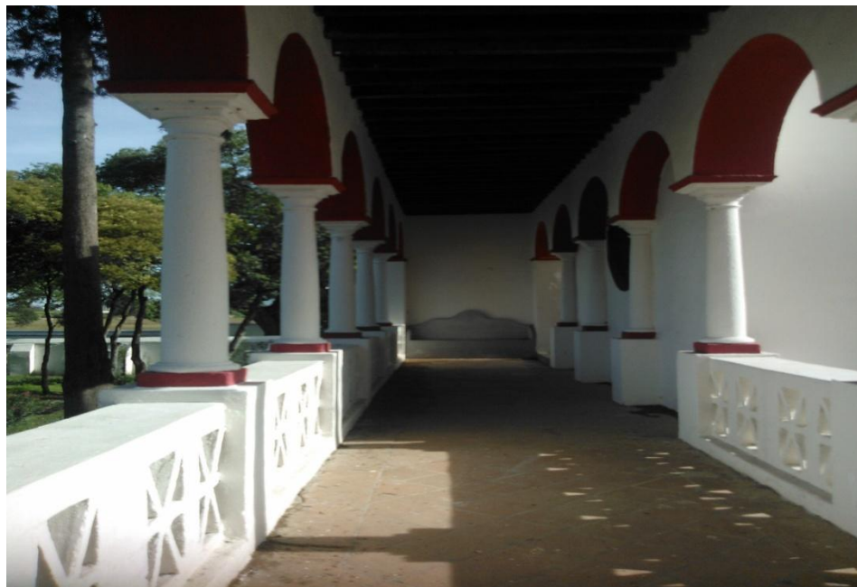
4.4.- Arcada interior apoyada en pilastras de cantera.
