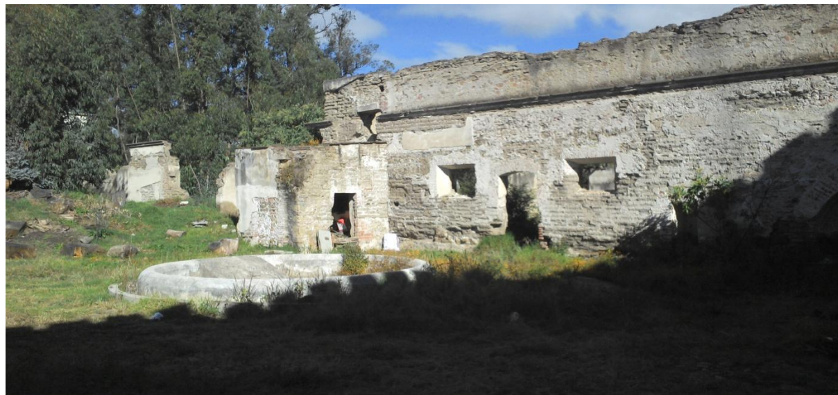
4.1.- Vestigios de las habitaciones secundarias y el comedor de lo que fuera el primer edificio de la Ex Hacienda de Chautla, actualmente en un total estado ruinoso.
