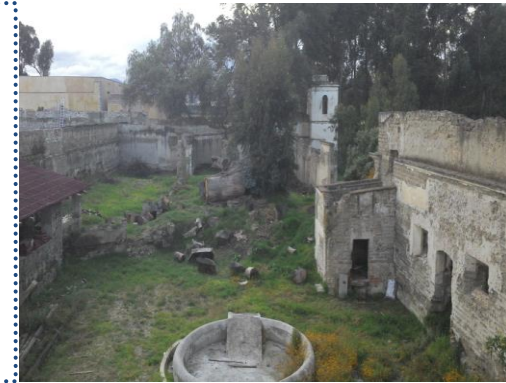
11.-Antiguo jaguay y habitaciones secundarias de la Ex Hacienda de Chautla hoy en total estado ruinoso.
