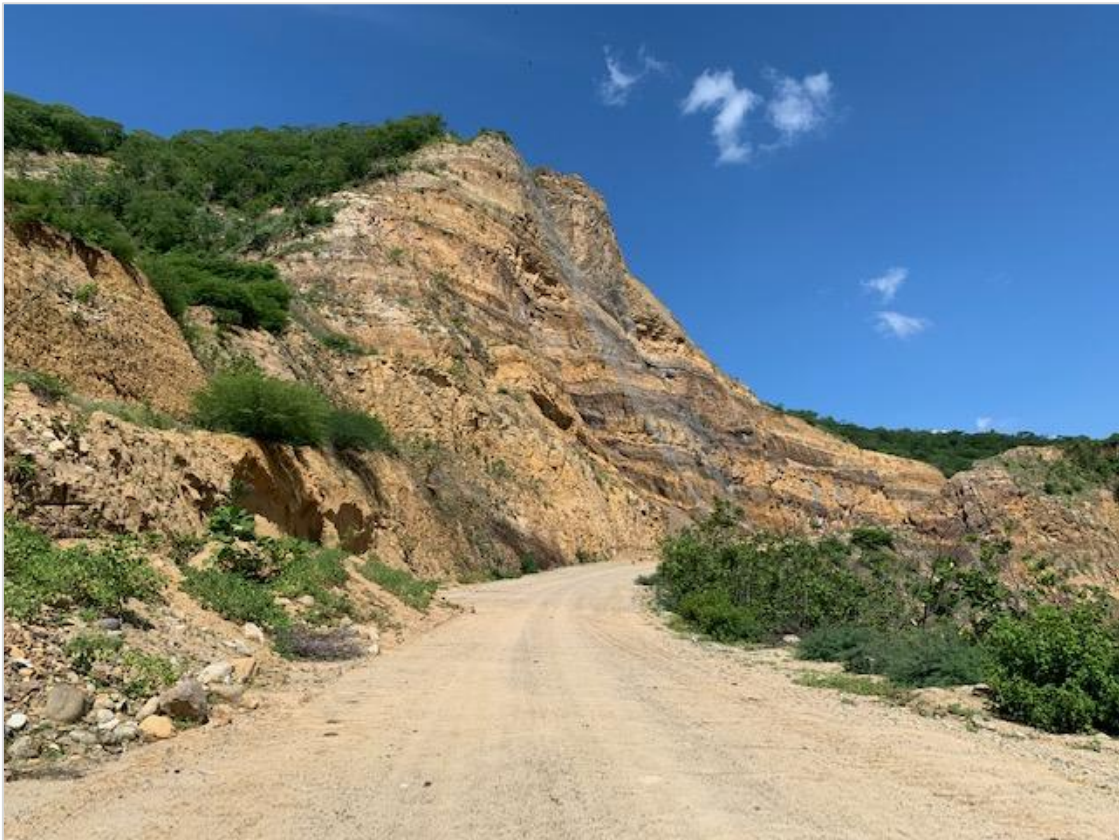
Figura 5.1 Panorámica de talud en estudio en la región sureste del estado de Oaxaca.
