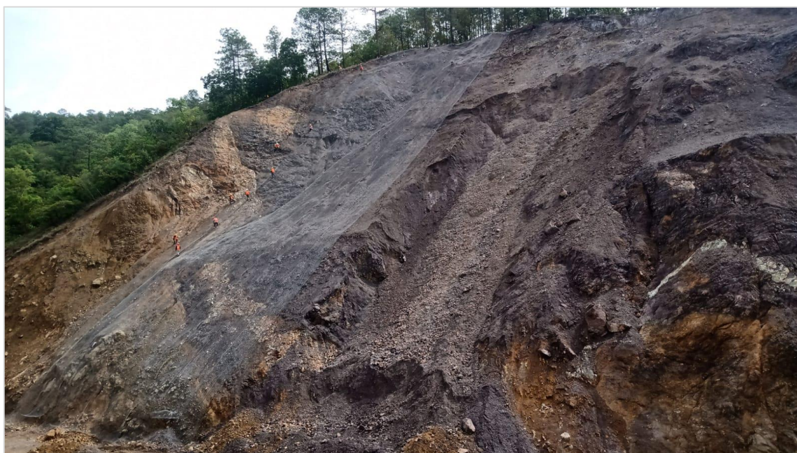
Figura 4.1 Trabajos de amacice en talud.
