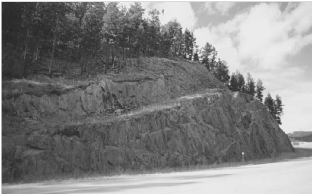
Figura 4.5 Berma construida paralela a la topografía de carreteras (Kliche, 1999).
