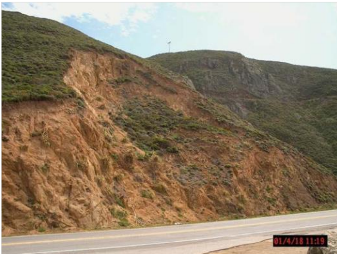
Figura 2.8 Falla circular en roca granítica muy erosionada (Wyllie & W Mah, 2005).
