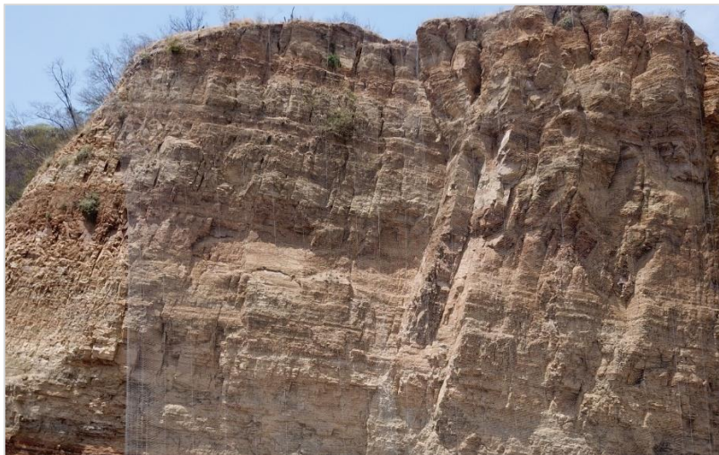
Figura 1.10. Observación de estratigrafía y discontinuidades que puedan provocar caídos de bloques por cuña, haciendo uso de VANT en talud en corte de autopista de la región sureste del estado de Oaxaca.
