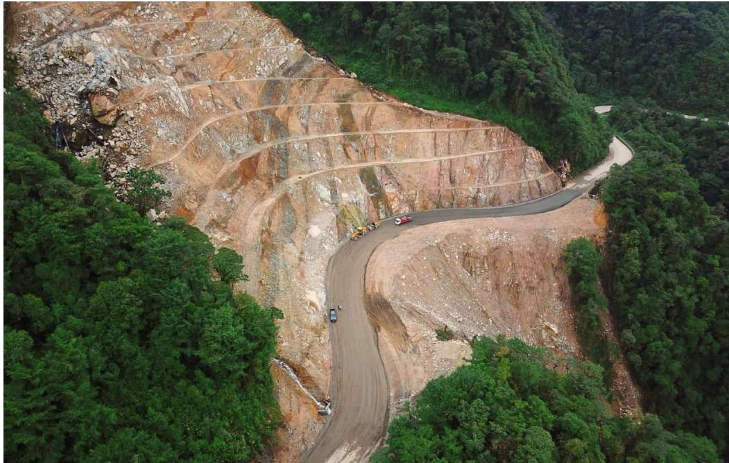
Figura 4.4 Bermas con pendiente transversal y longitudinal (Martínez, 2020).
