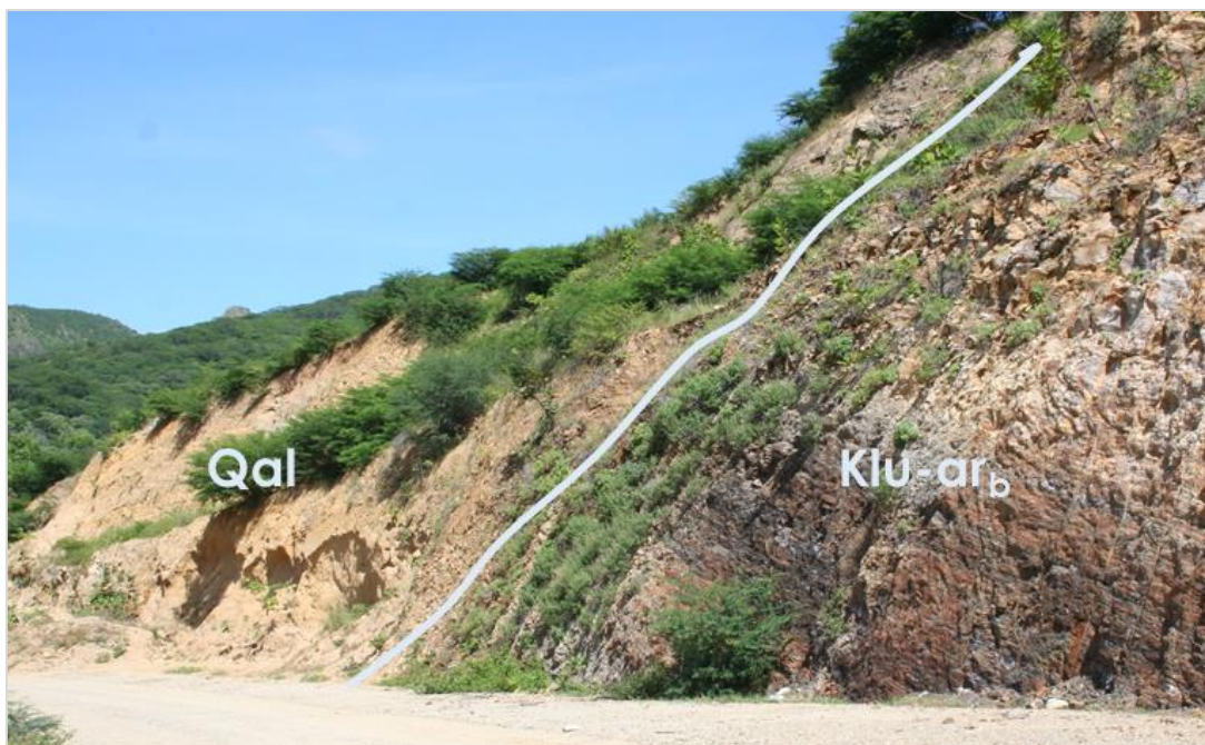
Figura 5.8 Contacto entre las unidades tipo flysch y los depósitos aluviales al inicio del corte.
