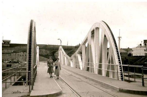
Fig. 4 Puente ferroviario Hendon Dock
