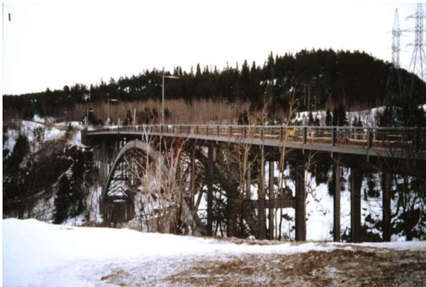
Fig. 3 Puente vehicular Arvida
