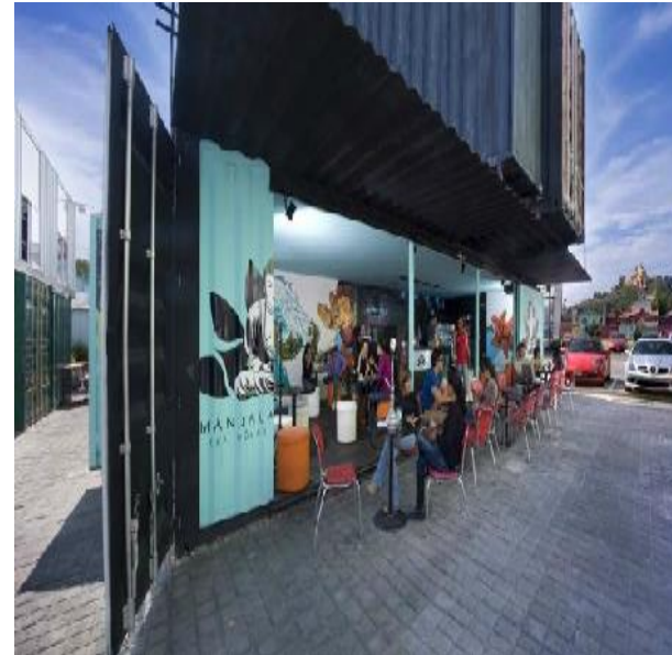
Foto 1.3.3.1 Fachada, Container City, San Andrés Cholula, Puebla.
