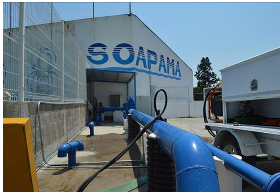
Foto 4.2.7 SOAPAMA, Agua potable, Atlixco, Puebla.
