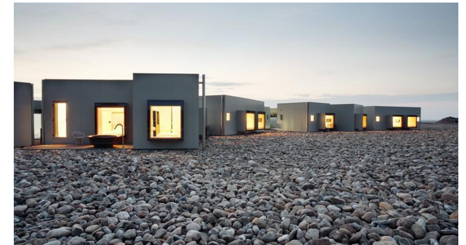
Foto 1.3.1 Hotel Aire de Bardenas, España.
