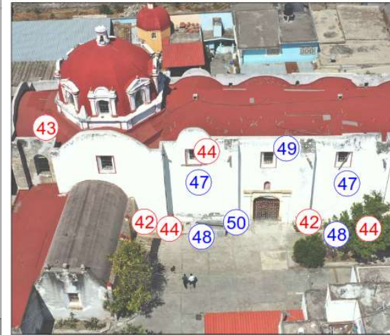
Imagen 53: Vista general de el muro sur del templo
