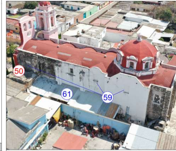
Imagen 65: vista general del muro norte del templo.
