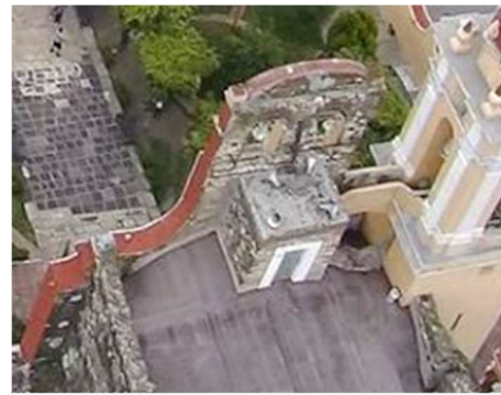
Ilustración 141: Espadaña y cuarto de máquinas en bóveda del primer tramo antes del sismo. Autor: Desconocido
