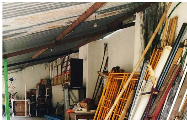
Ilustración 110: Cubierta de perfiles de acero y lamina de zinc adosada al muro norte del templo parroquial. Autor: SLF
