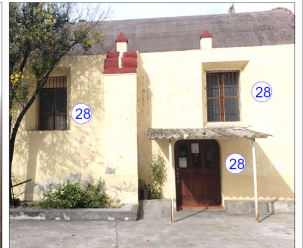
Imagen 36: apertura de vanos de puertas y ventanas vistas por el exterior en muro oriente.
