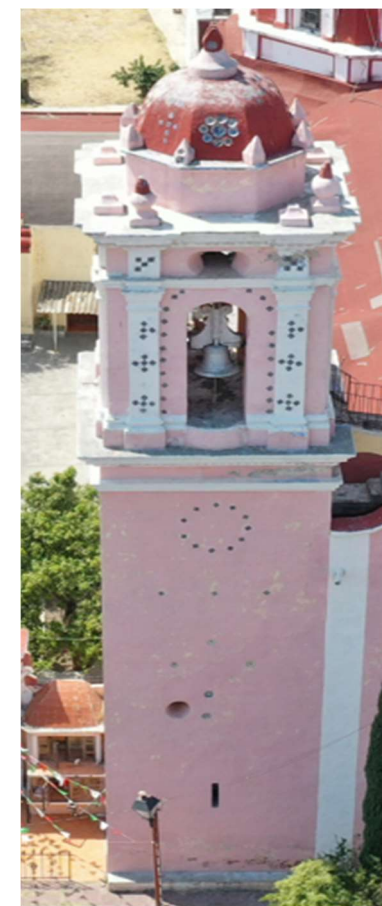
Ilustración 61: fachada oriente del campanario. Autor: SLF
