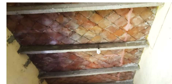
Ilustración 104: Losa catalana con vigas de concreto armado, se observan los huecos cegados de las vigas de madera del sistema original. Autor: SLF
