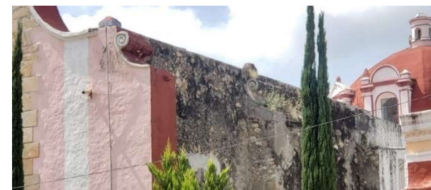
Ilustración 72: Roleos en los contrafuertes 8 y 10, los contrafuertes de los ejes anteriores carecen de ornamentación. Autor: SLF
