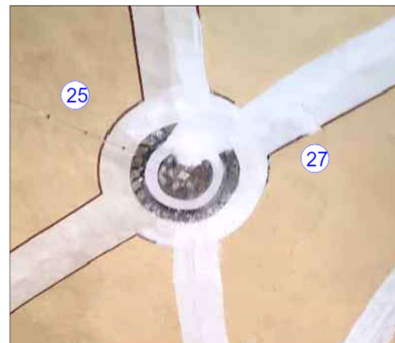
Imagen 29: alteración los patrones geometricos y color de pintura en cubierta de baptisterio
