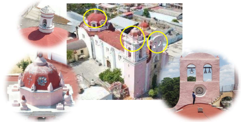
Ilustración 139: elementos no estructurales en la parroquia de San Martín Obispo. Autor: Samuel López Flores
