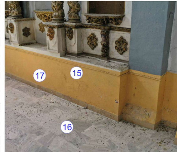
Imagen 19: aplanados de mortero cemento-arena e instalaciones superficiales sobre base de retablo.
