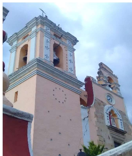
Ilustración 41: Colapso de espadaña en el sismo del 19 de septiembre de 2017. Autor: Isaacvp Fuente: https://es.wikipedia.org/wiki/Archivo:Templo_y_Antiguo_Convento_de_San_Mart%C3%A9n_Obispo,_Huaquechula,_Puebla.jpg
