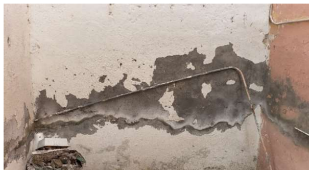
Ilustración 111: integración de aplanados cemento-arena en el muro sur del templo parroquial. Autor: SLF
