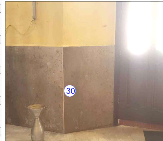
Imagen 35: colocación de lambrines de marmol.
