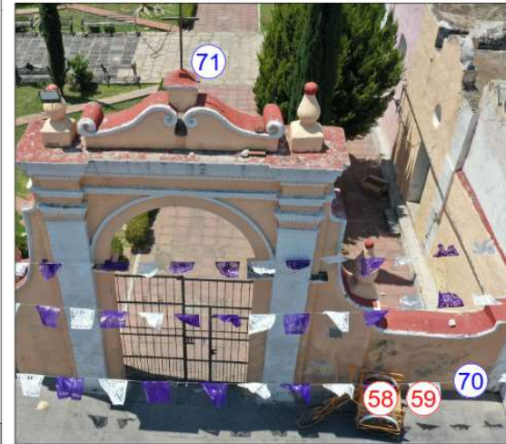
Imagen 78: Acceso norte exterior
