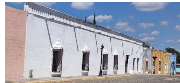
Ilustración 36: Perfil de la calle de la casa de la Palestina en 2023. Autor: Arq. Zaida Ramírez Delfín.
