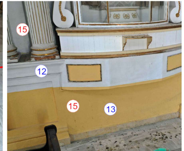
Imagen 16: Aplanados con mortero cemento-arena en base para retablo en muro sur e instalación eléctrica superficial.
