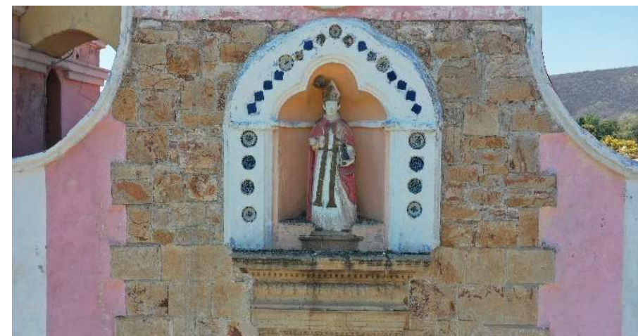
Ilustración 73: Manufactura de piedra de cantera diferentes en la fachada principal. Fuente: Autor: SLF
