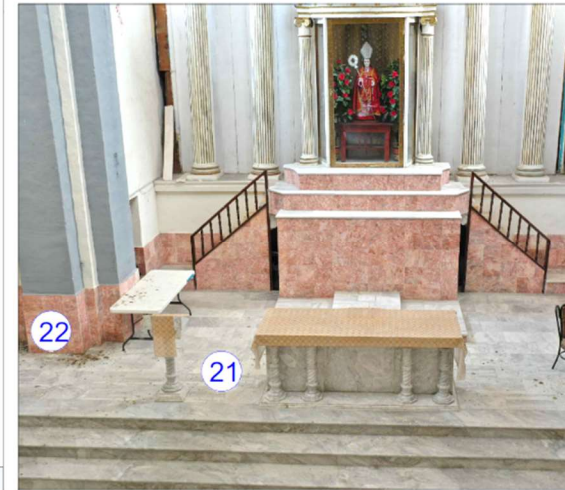
Imagen 25: Sustitución de pisos originales por pisos de marmol y colocación de lambrines de marmol.
