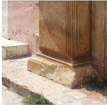
Ilustración 115: Desgaste de pilastras de cantera amarilla en la fachada oriente. Autor: SLF
