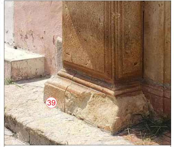
Imagen 50: desgaste de basas de la portada principal.
