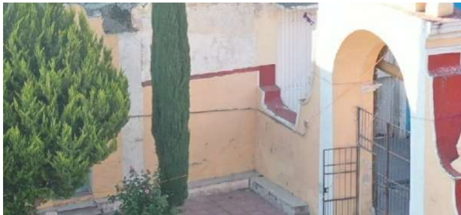
Ilustración 47: Construcción de muro y cubierta sobre la barda atrial. Autor: SLF
