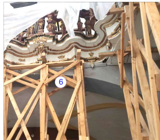
Imagen 9: Apuntalamiento de balaustrada en el tramo 1.
