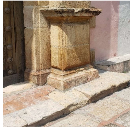
Ilustración 115: Desgaste de pilastras de cantera amarilla en la fachada oriente. Autor: SLF
