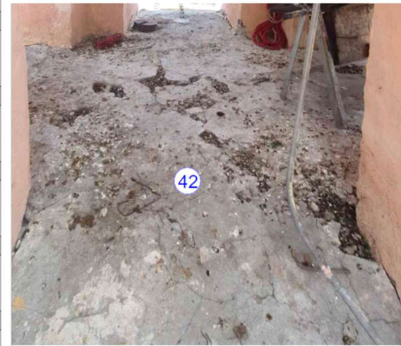
Imagen 47: construcción de losa intermedia de concreto en el campanario.
