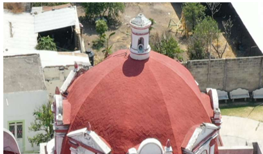
Ilustración 105: linternilla sobre cúpula en 2023. Autor: SLF
