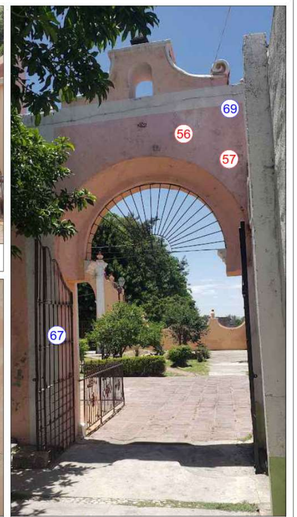
Imagen 77: Fachada poniente del arco de acceso poniente.
