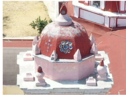
Ilustración 106: pináculos a nivel del cupulín y testimonios de los pináculos faltantes. Autor: Arq. Samuel López Flores
