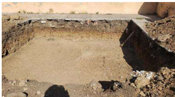
Ilustración 97: Terreno tipo II tepetate en la construcción de la torre del reloj en el atrio. Autor: SLF
