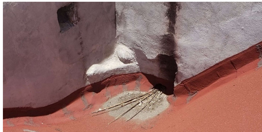
Ilustración 114: obstrucción de bajadas pluviales por acumulación de basura y ceniza. Autor: Samuel López Flores
