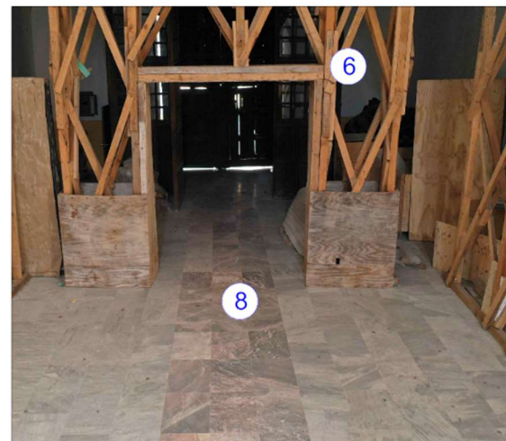
Imagen 11: Sustitución de pisos originales por piso de marmol.
