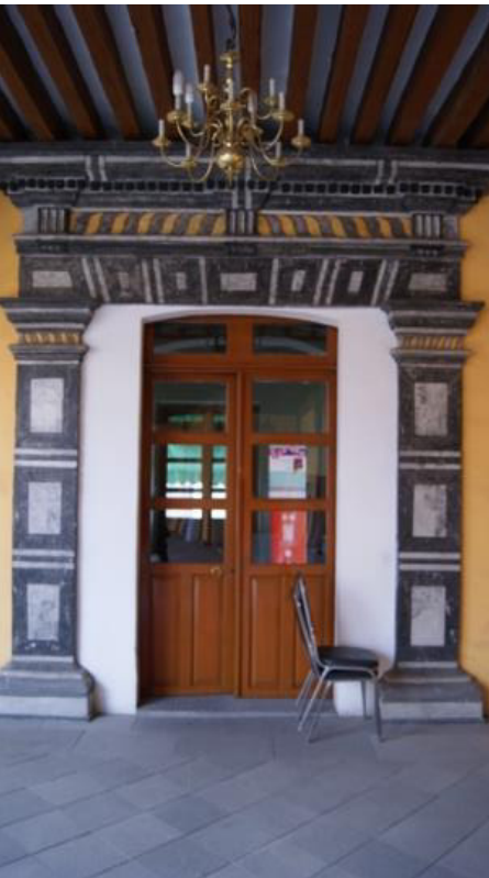
Crujía Porticada, Foto por autores de Tesis
