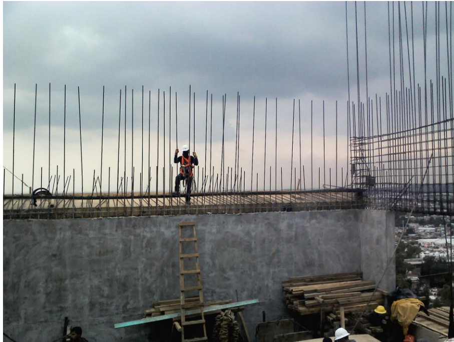
Curado de muros de concreto
