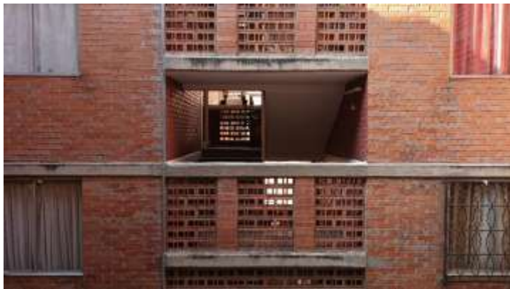
IMAGEN 40 Es común que los residentes de los departamentos de edificios interconectados mantengan cortinas y persianas sin correr como medio de contención de lo privado. No son más de cuatro metros los que separan los departamentos. Fuente: Propia, 2024.
