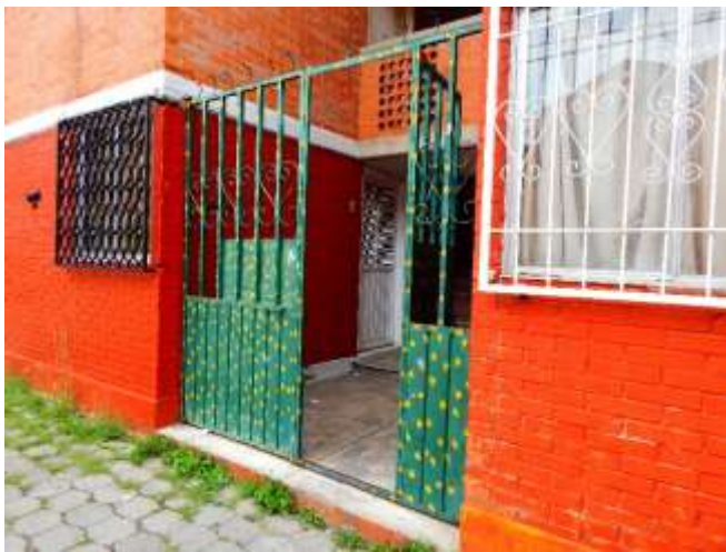
Imagen 42 Los diseños, colores, formas y tamaños de los portones dependerán de los acuerdos entre vecinos, lo que sí es fundamental, es que estos dispositivos no impidan el acceso al personal de la CFE. También pueden apreciarse las ventanas de ambos departamentos enmarcadas por protecciones. Fuente: Propia, 2024.
