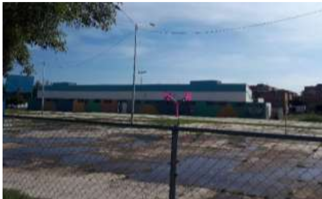
Imagen 87 Toda la parte de colores debajo de las gradas, es el espacio que habitan los vecinos cuidados de las canchas. Vista desde el parque de los perros. Fuente: Propia, 2022.
