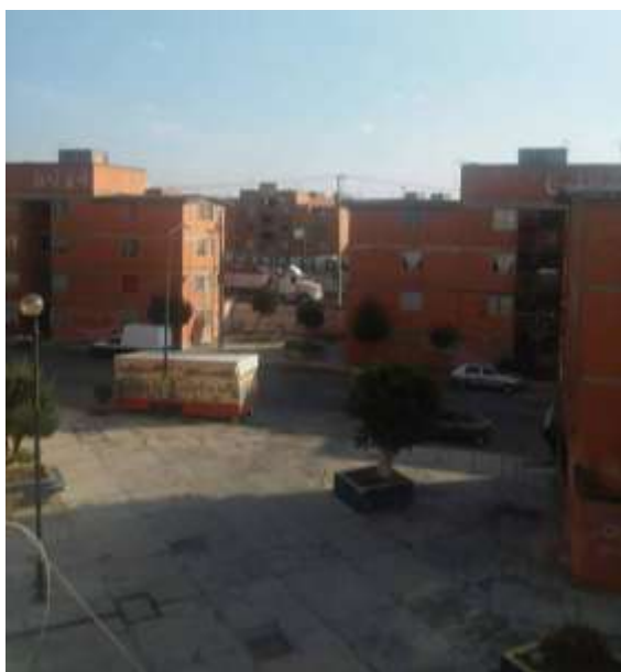
IMAGEN 31 El característico color anaranjado ladrillo de las unidades habitacionales del sur de la ciudad. Fuente: FB_SanBarcholos, 2019
