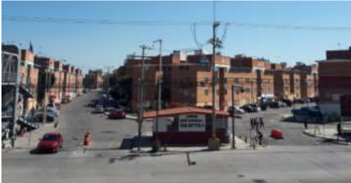
Imagen 94 En rojo y blanco, los colores de la nueva administración de gobierno, se observa la caseta principal de vigilancia, en la esquina de la avenida 11 sur y la calle 107 poniente la cual pertenece a la colonia Coatepec. Es la única de las cuatro casetas que aún desempeña su labor. Fuente: Propia, 2024.
