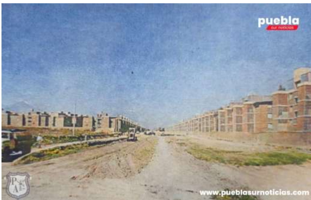
IMAGEN 23 Comienzan los trabajos de construcción del Anillo Periférico a comienzos de 1994. De lado izquierdo, la Unidad Habitacional Agua Santa y de lado derecho, la Unidad Habitacional San Bartolo, ambas ya construidas y comenzando a habitarse, compartiendo el terreno que en algún momento fue la Hacienda San Bartolo Coatepec. Fuente: https://www.pueblasurnoticias.com/
