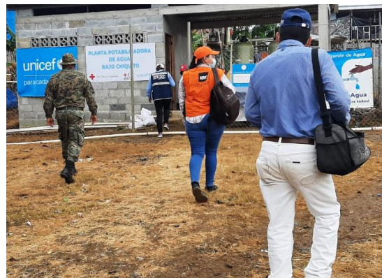
Foto 2.18: Planta potabilizadora de agua financiada por UNICEF Tomada en febrero 2022
