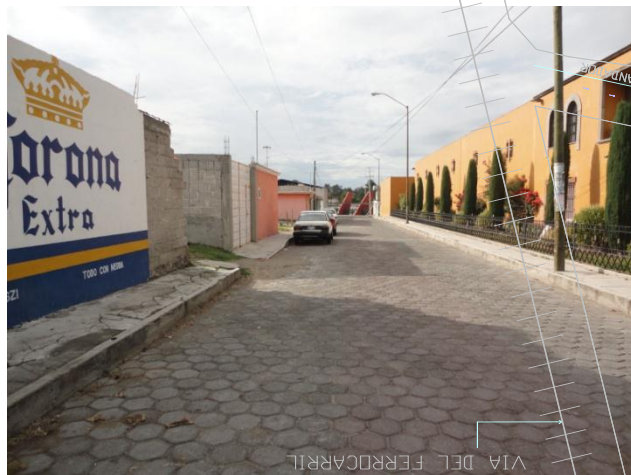
ACCESO CALLE 20 DE ENERO
