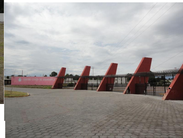
ACCESO CALLE 20 DE ENERO
