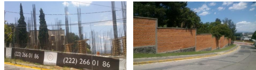
Zapatas y Columnas-Cimiento de Mampostería y muros de tabique rojo Fuente: Leonardo De La fuente Ibarra
