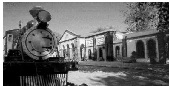
Estación del ferrocarril interoceánico. Ciudad de Puebla Fuente: http://www.bing.com/imagenes
