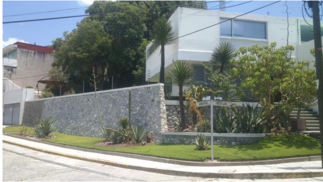
Acabados de piedra en fachadas Fuente: Leonardo De La fuente Ibarra
