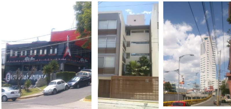
RockStar, Edificio Condominio, Torre JV Fuente: http://cuartoscuro.com/ELADIO_6.jpg
