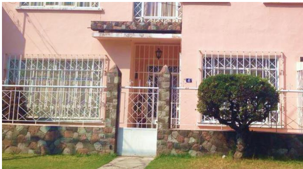
Materiales y acabados empleados en fachada. Fuente: Liliana González
