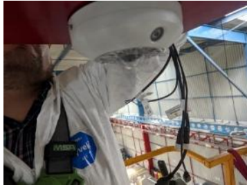
c) Instalación de cámaras
