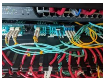
c) Colocación en distribuidor de fibra
