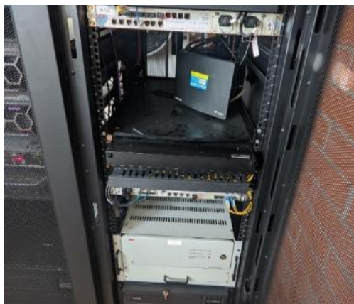
c) Migración de enlaces e instalación de UPS
