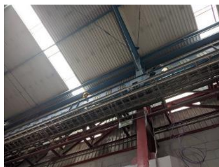
b) Tendido de cable en producción
