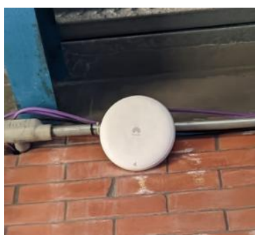
c) Instalación de los AP
