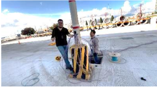
a) Proceso de cableado tubería interna
