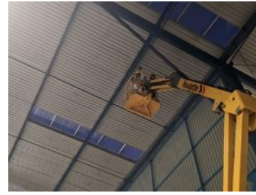
b) Tendido de cable en producción
