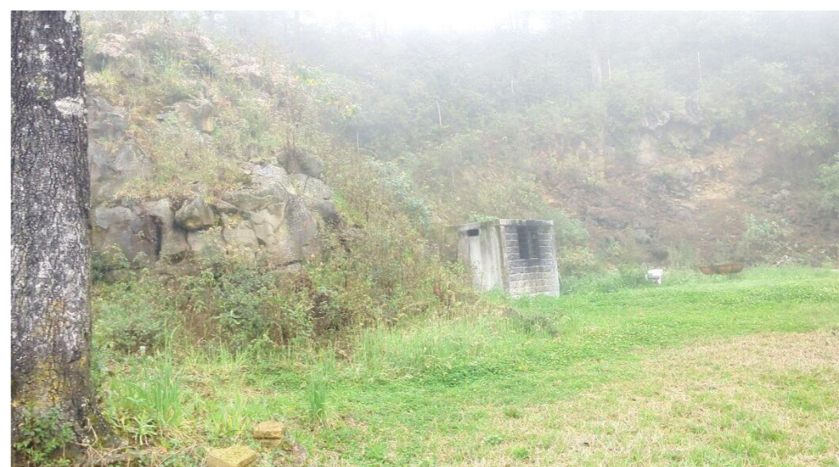
Fotografía 7. Vista exterior, hacia área de pruebas de incendio. Elaboración propia.
