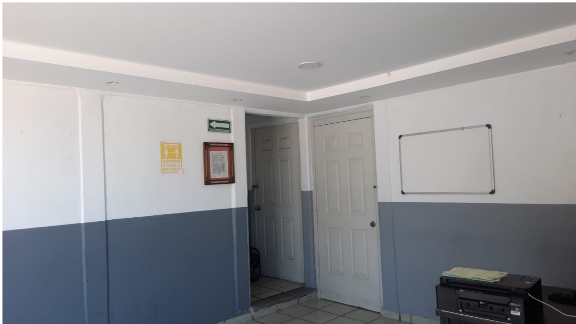
Fotografía 23. Vista interior, acabados en oficinas. Elaboración propia.
