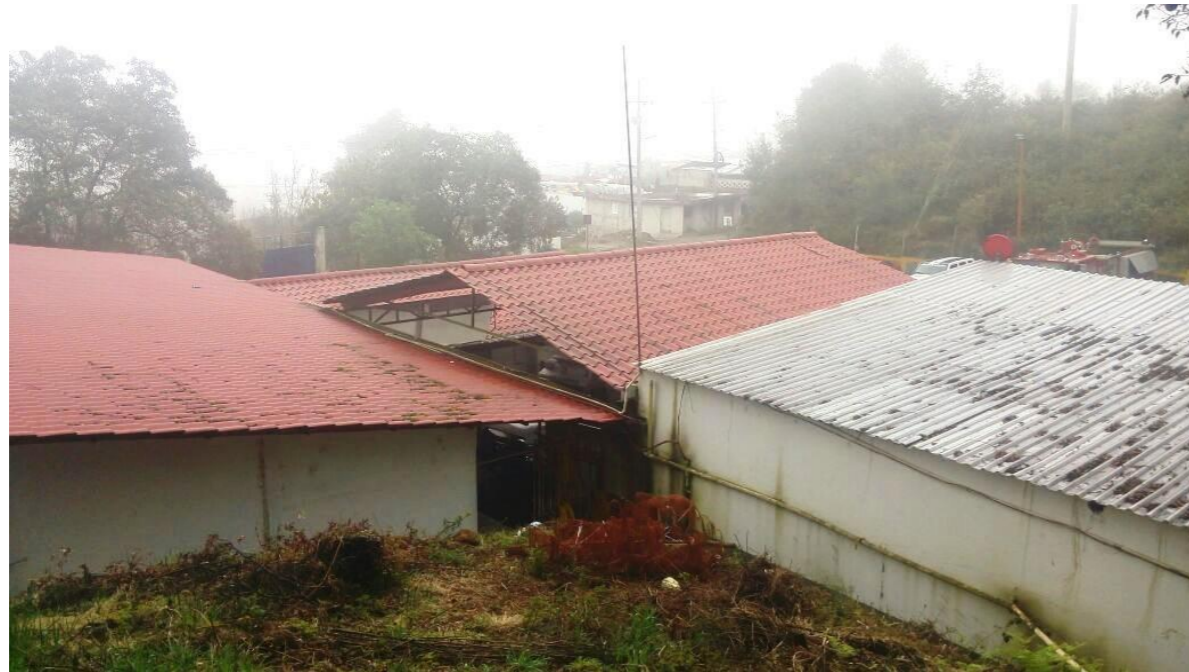
Fotografía 4. Vista exterior, hacia cubiertas. Elaboración propia
