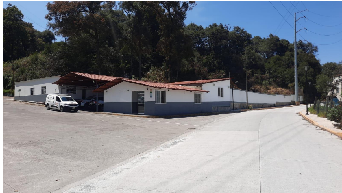
Fotografía 1. Vista exterior, desde avenida. Elaboración propia.
