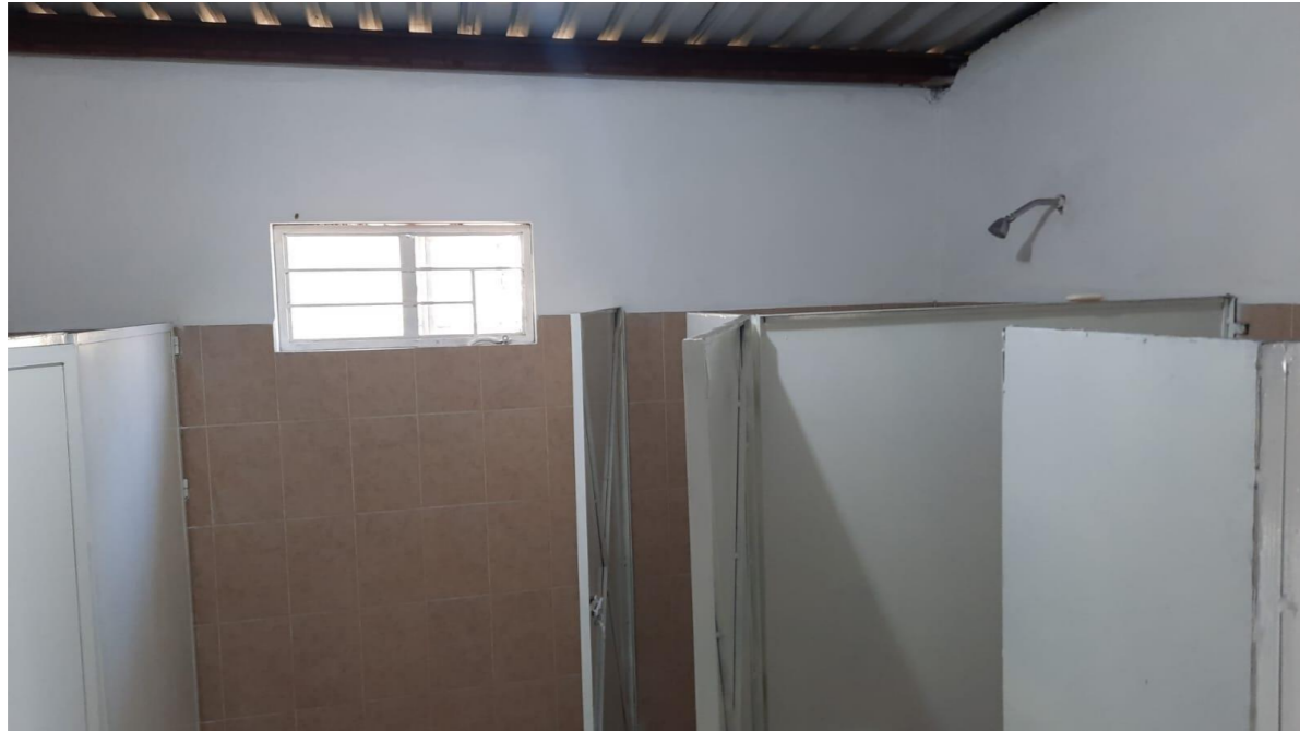
Fotografía 22. Vista interior, acabados en sanitarios. Elaboración propia.
