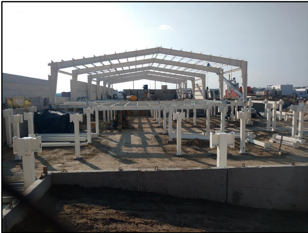
Fig. II.7 Nave industrial en proceso de construcción (autoría propia, 2020)
