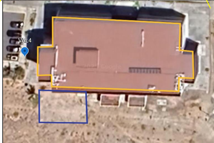
Figura 32 Edificio VAL 4, ubicado en el ecocampus BUAP.
