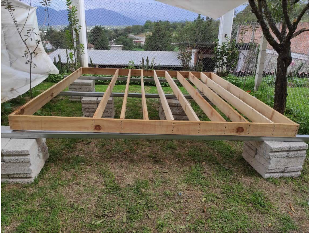
Imagen 5. Fin de la primera etapa del ensamble de sistema Charola Flotante.
