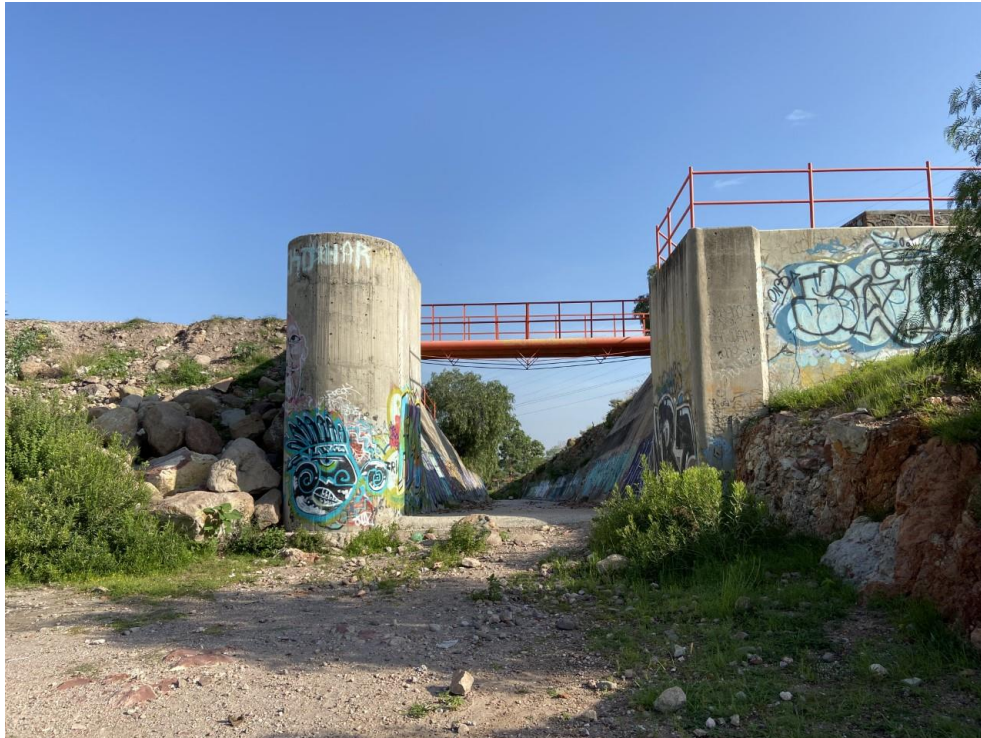
Imagen 1. Vertedero de la presa Cañada del Lobo
