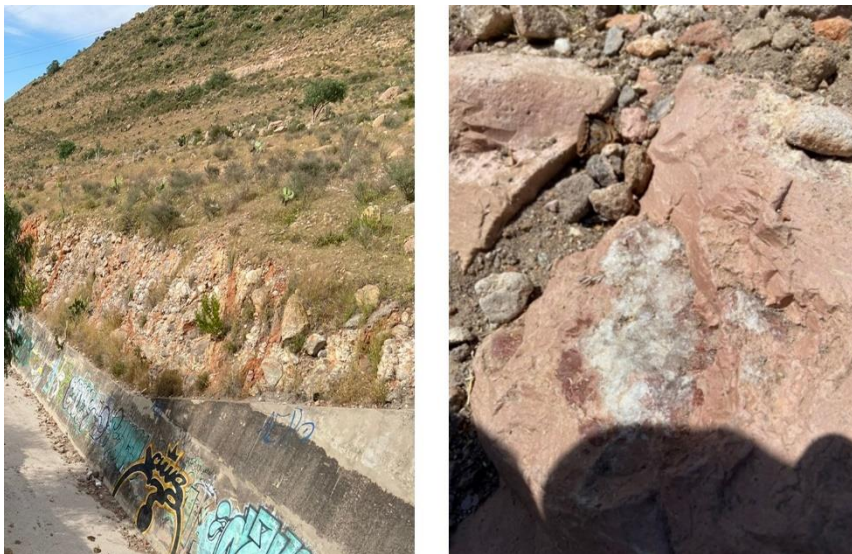
Figura 31. a) Corte geológico encima del final de la obra de excedencias. b) Riolita con disgregado calcáreo.
