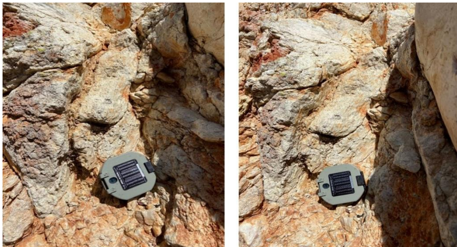
Figura 30. Estrías de rocas producto de desplazamiento de bloques o fracturas en un plano de falla pegado a la pared donde inicia la obra de excedencias (CDL).
