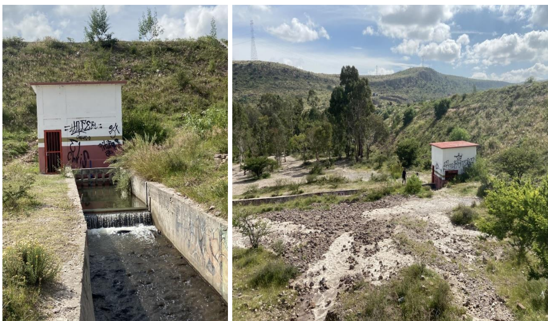
Imagen 2. Caseta de operación aguas abajo de la cortina de la presa Cañada del Lobo.
