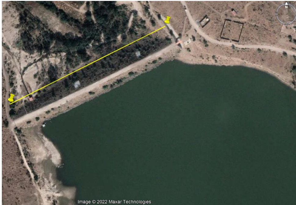
Figura 23. Perfil 2. TER automática al pie de la cortina aguas abajo de la presa Cañada del Lobo. Elaborado con Google Earth.
