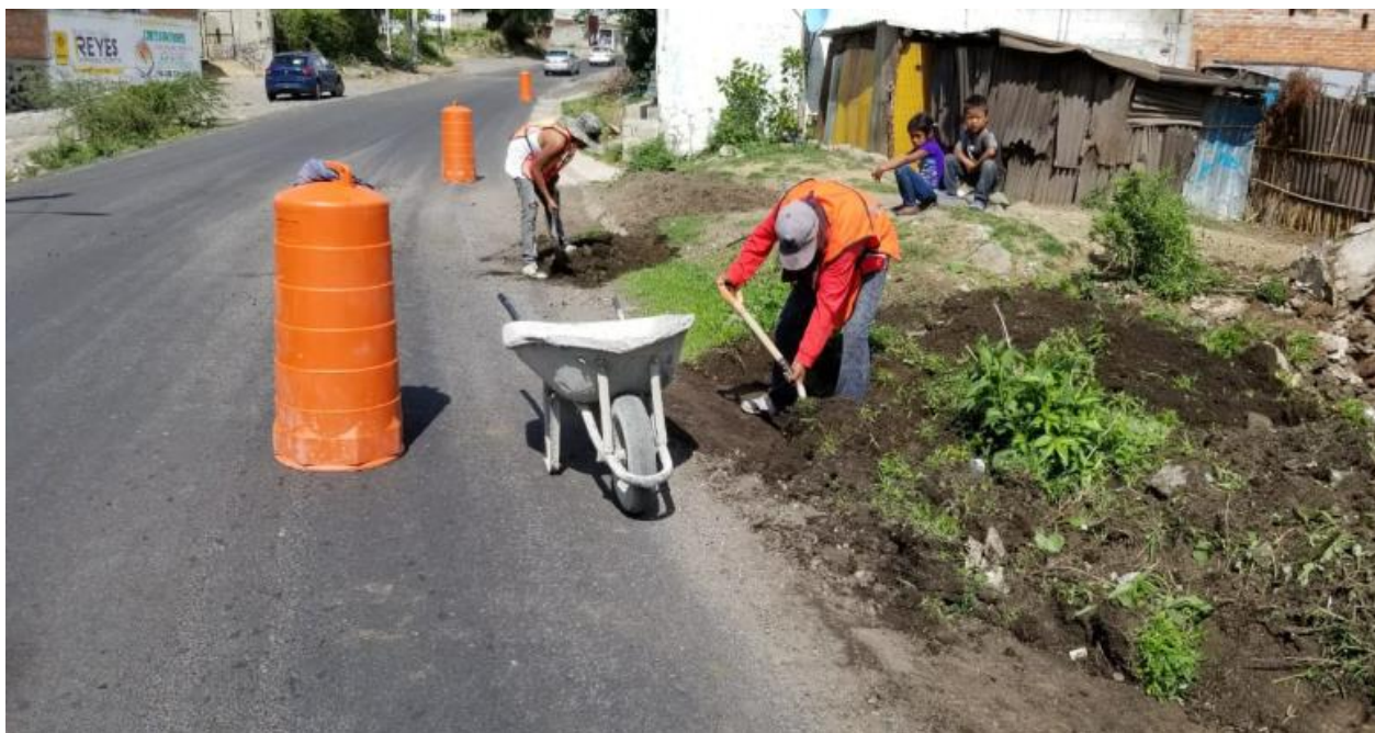
Fig. 9 Limpieza del terreno
