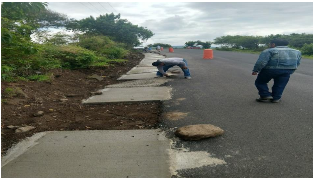
Fig.- 8 Colocación de zampeados
