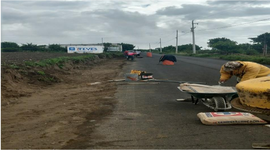
Fig.- 7 Elaboración de mezcla para zampeado
