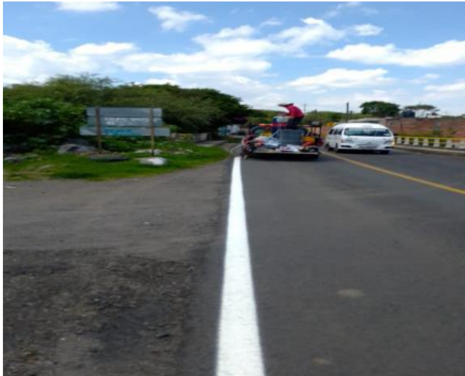
Fig.- 17 Rayas continuas en proceso de pintado
