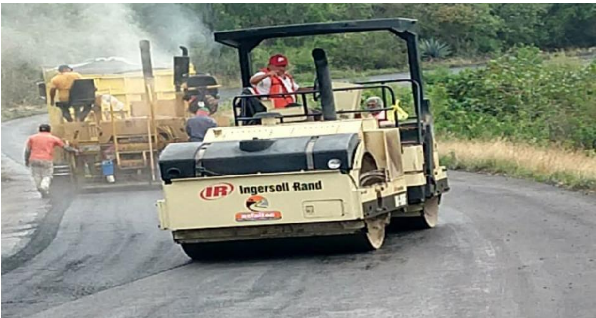
Fig.- 14 Vibro-compactación mediante rodillo liso
