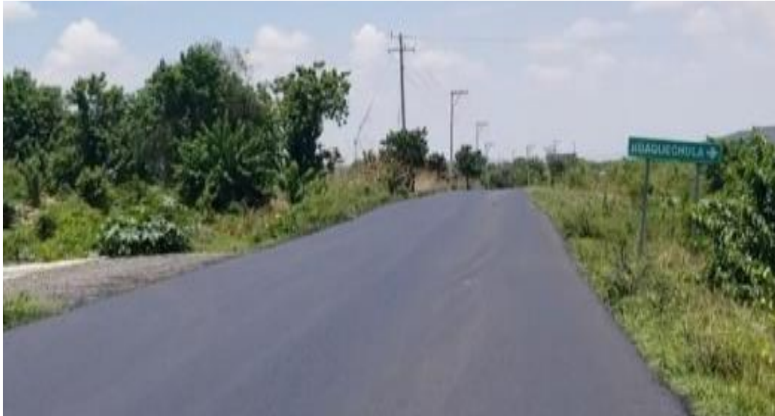
Fig.- 27 Señal de destino próximo
