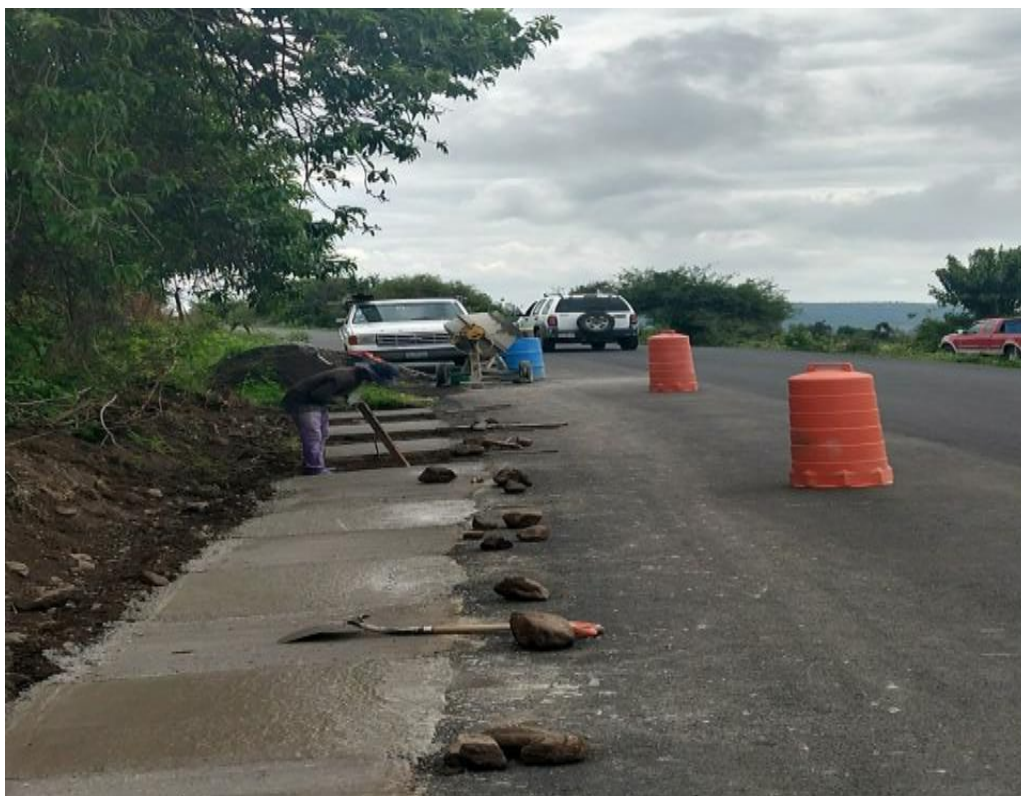
Fig.- 9 Zampeados en proceso
