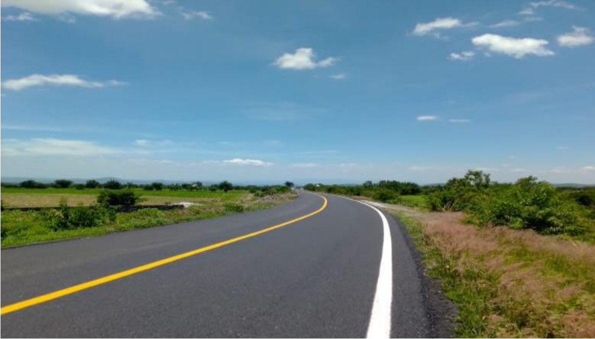
Fig.- 18 Terminado de carpeta y pintura de raya continua blanca y amarilla
