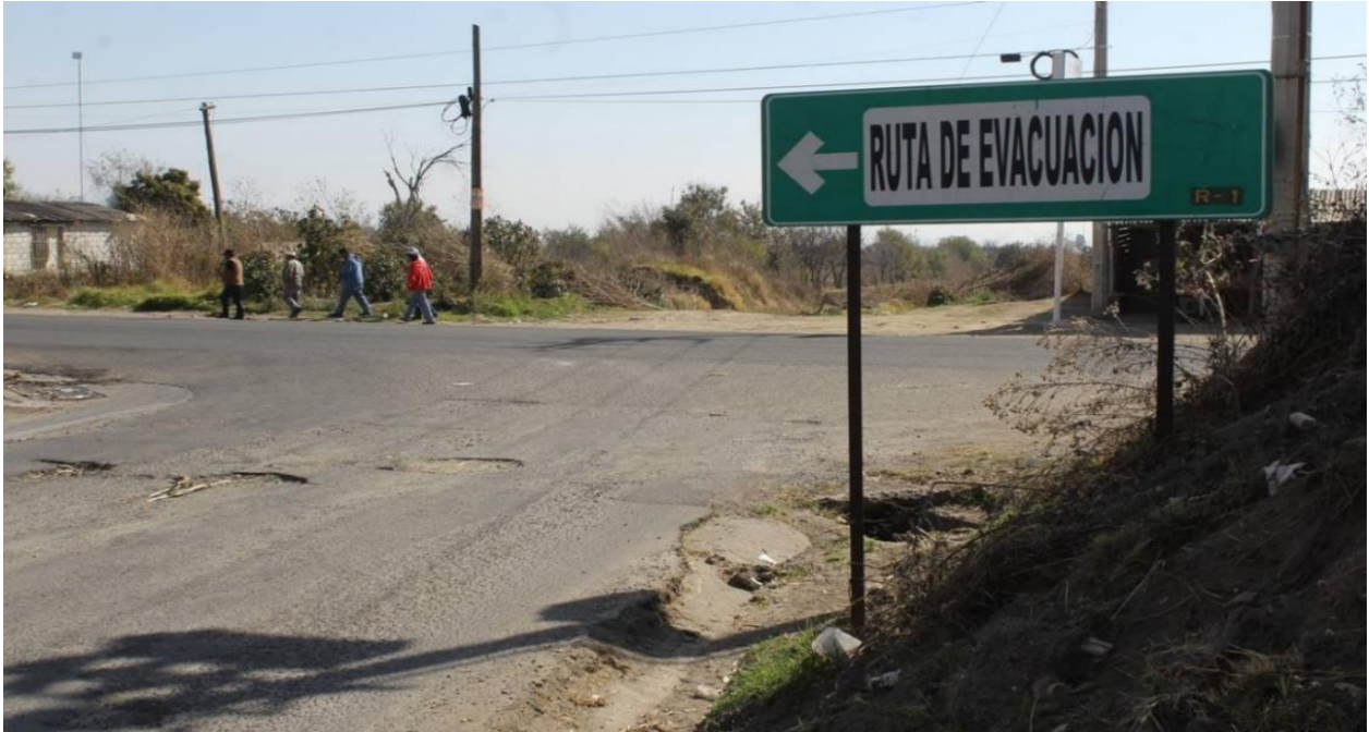
Fig. 4 Estado del camino antes de la rehabilitación, carretera con baches.
