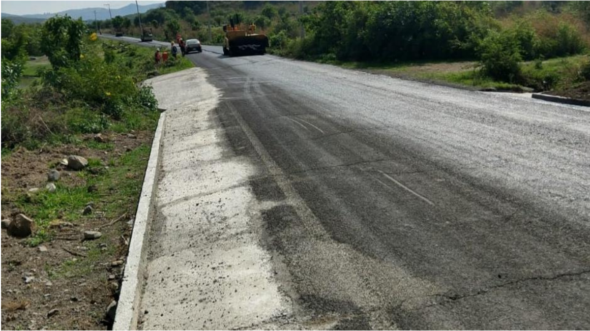
Fig.- 11 Zampeados listos junto con bordillo
