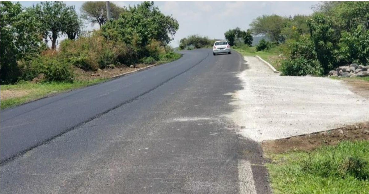
Fig.- 12 Zampeados, bordillo y arcén de emergencia concluidos
