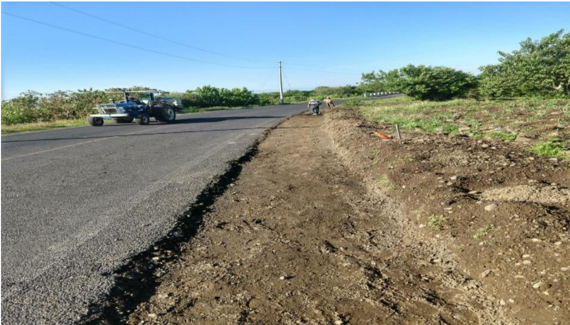
Fig.- 6 Terreno preparado para colocación de zampeados
