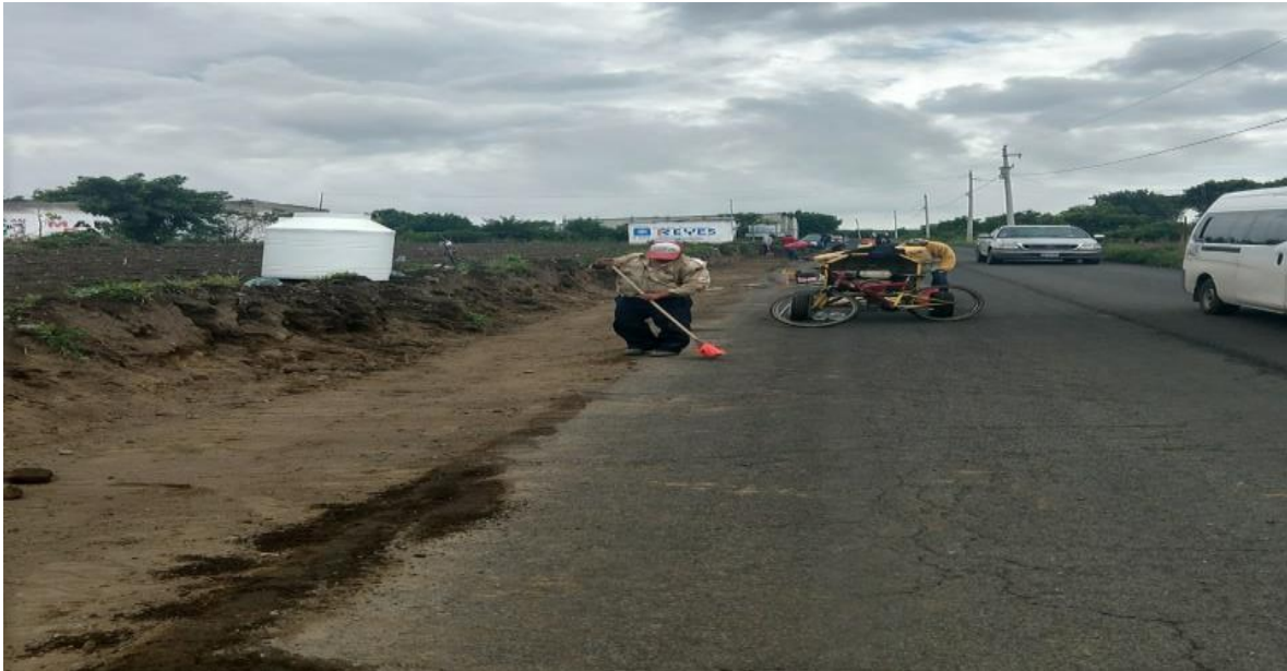
Fig.- 4 Relleno de la excavación y limpieza
