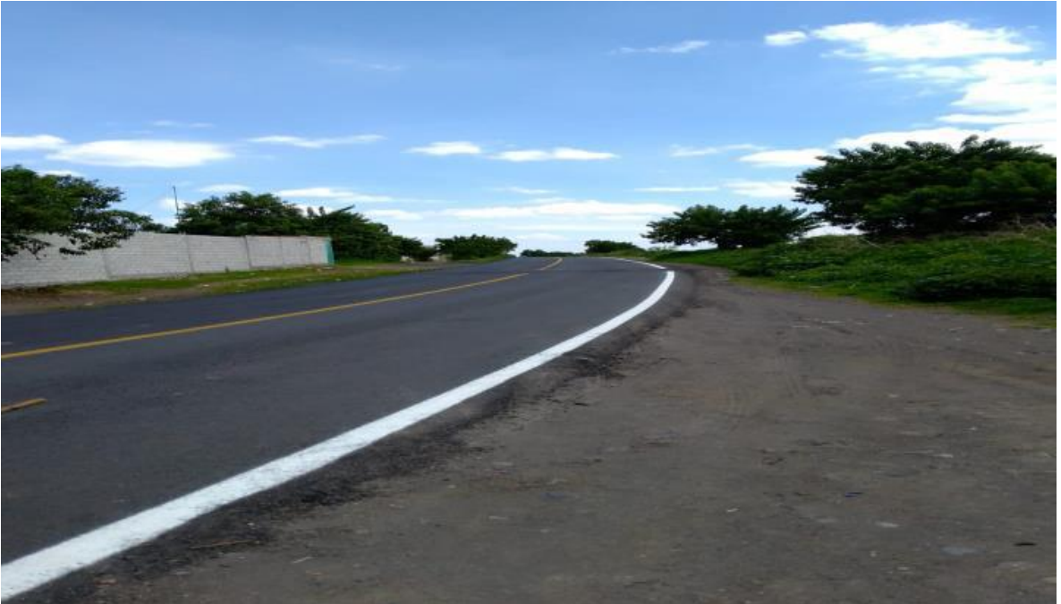
Fig.- 18 Terminado de carpeta y pintura de raya continua blanca y amarilla
