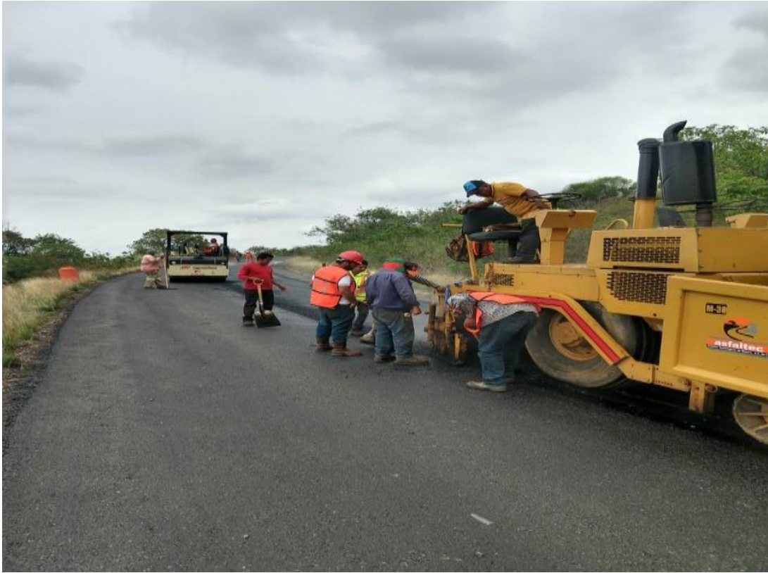
Fig.- 15 Revisión del tendido de carpeta
