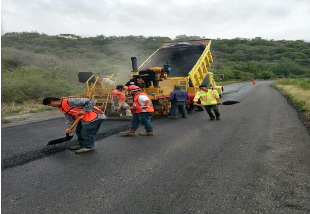
Fig.- 13 Colocación de carpeta mediante una extendedora Finisher
