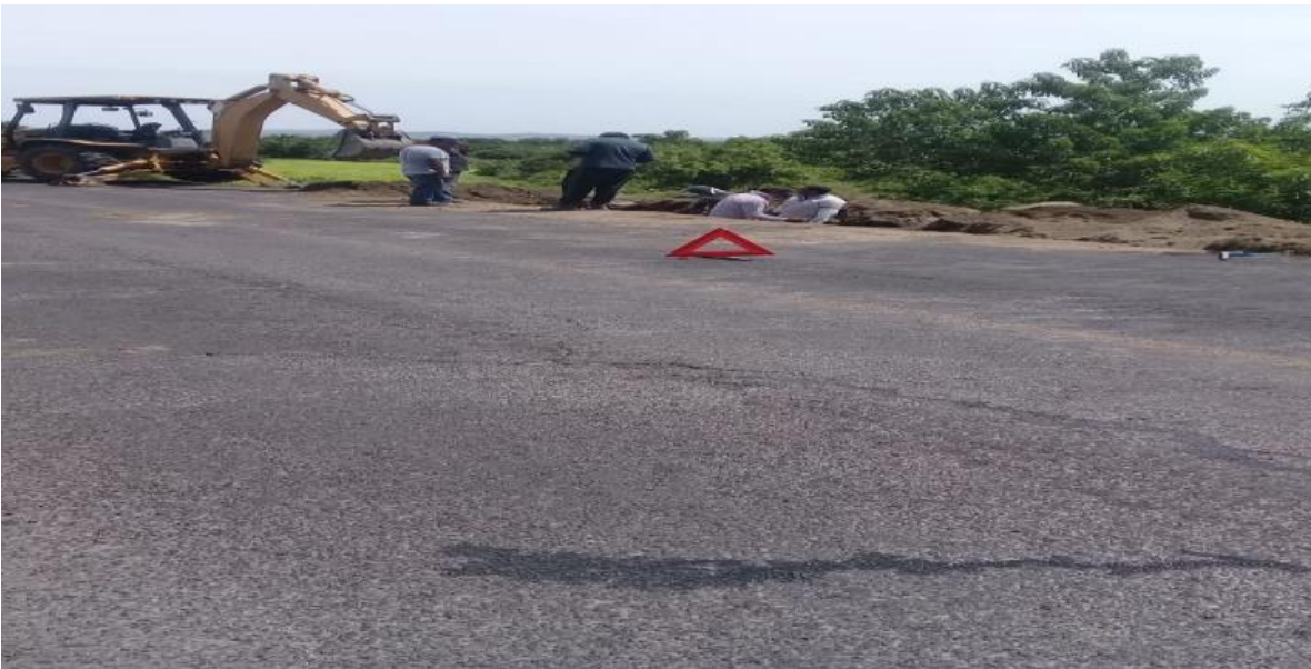
Fig.- 2 Supervisión de la excavación
