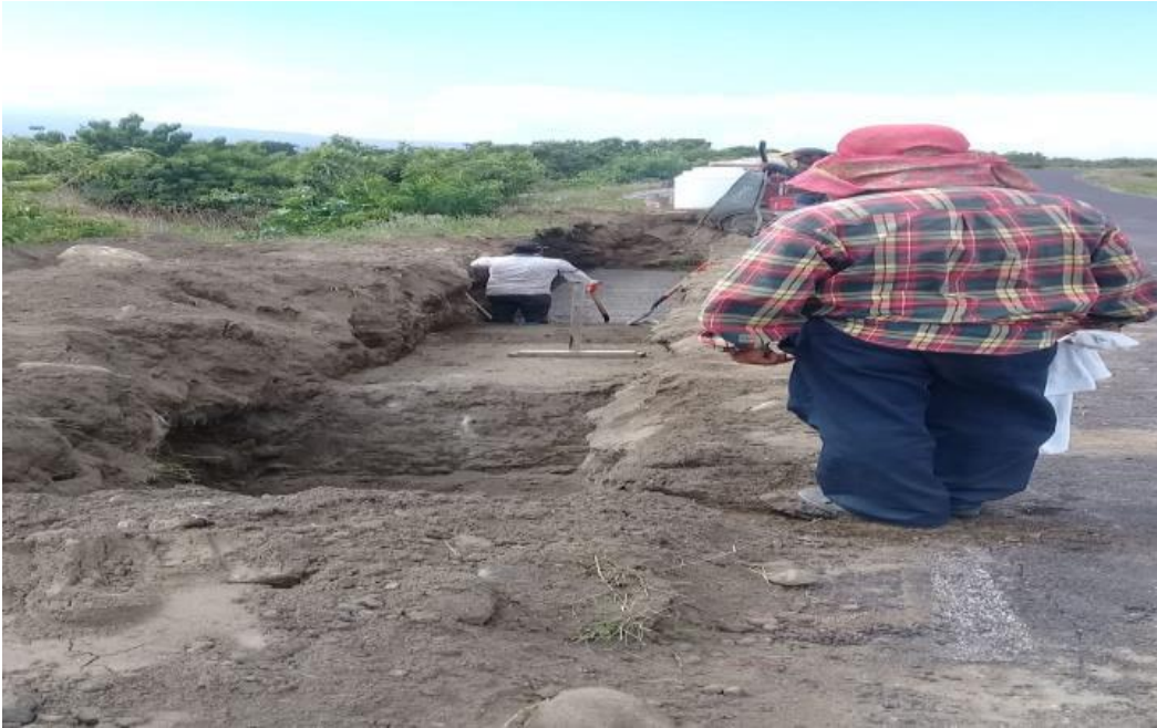
Fig.- 3 Colocación de plantilla en excavación
