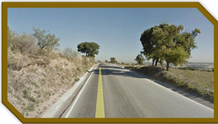
Imagen 20: fotografía del tramo pavimentado Periférico Ecológico-Relleno Sanitario.
